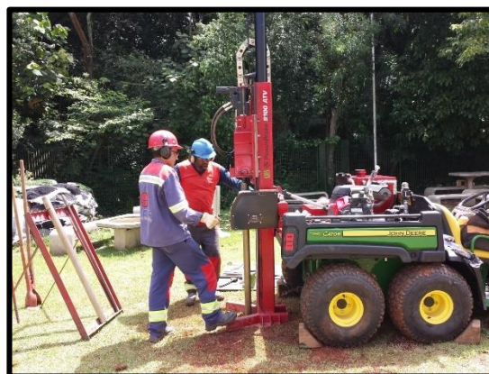
b) Sonda Power Probe cravando as ferramentas Dual Tube (Amostrador de aço com macrocore , liner e retentor de amostra)
