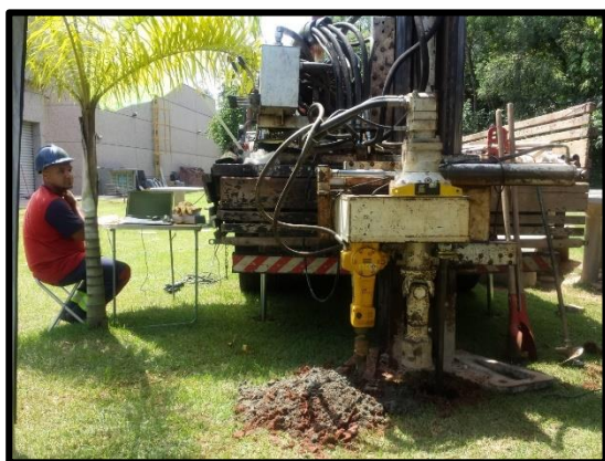
e) Ensaio CPTu sendo realizado por cravação de sonda hidráulica mecanizada sobre caminhão
