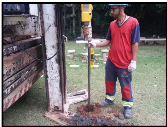
a) Nivelamento da primeira haste
