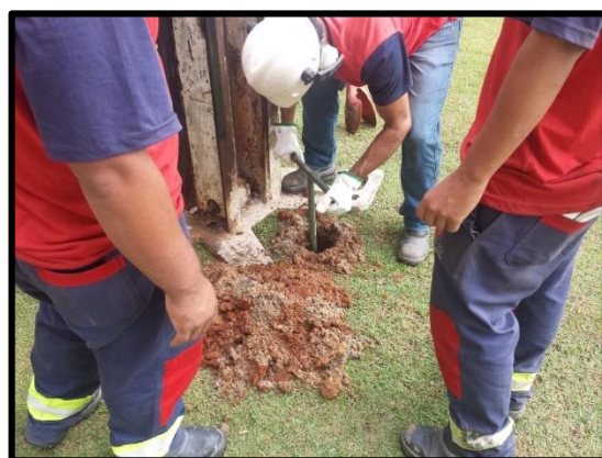
e) Pré-furo realizado com trado manual
