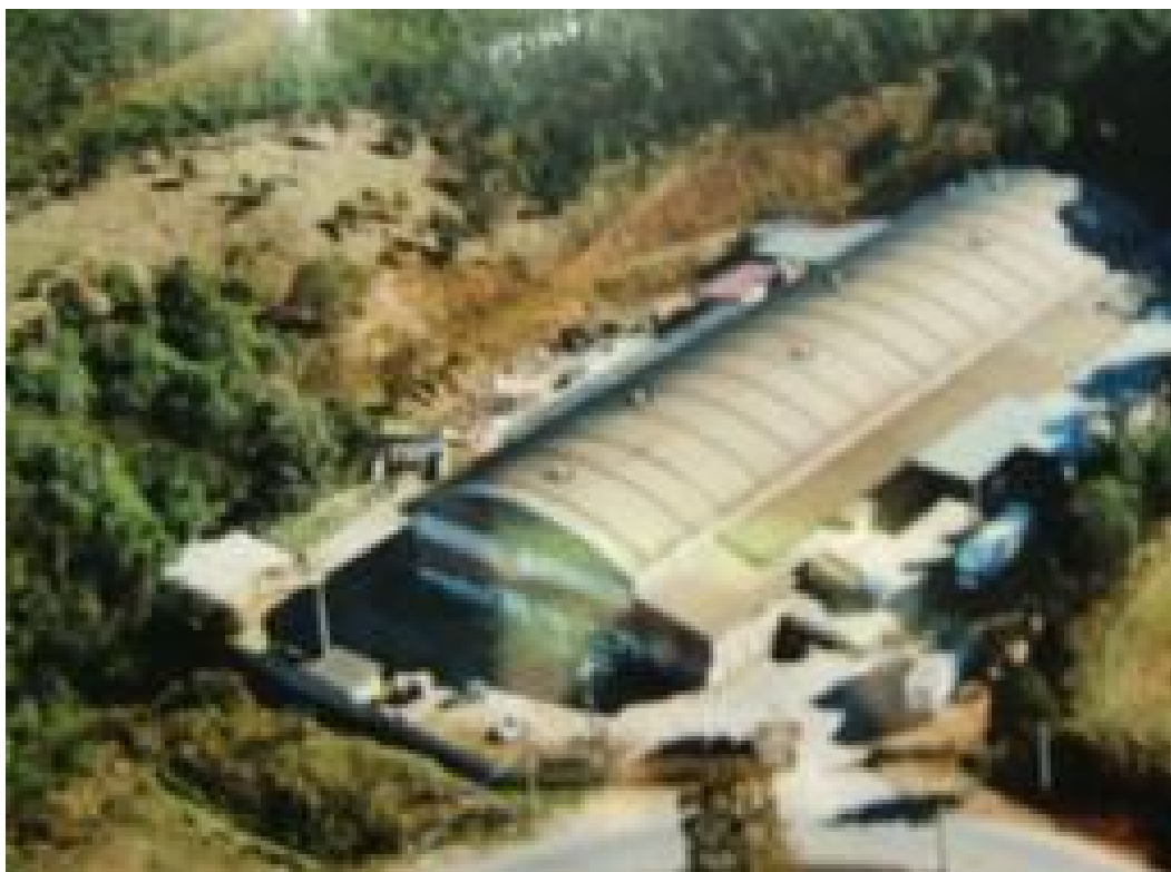
Figura 3.2 – Vista geral do talude
