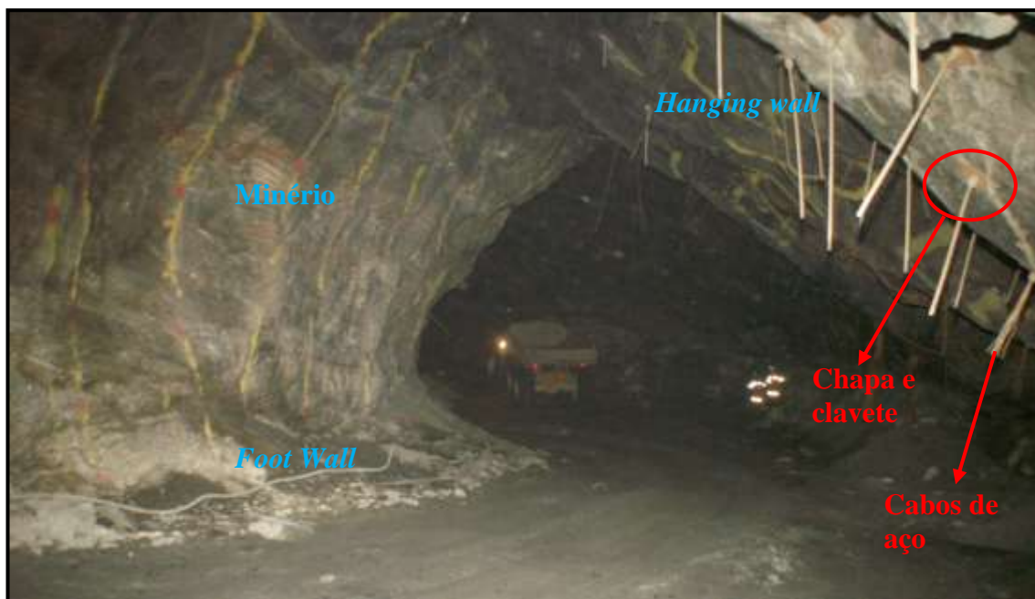
Figura 4.7- Visualização do realce 10.2 FGS, blocos 5 e 6A, com destaque para os cabos de aço utilizados como contenção e as chapas e clavetes.
