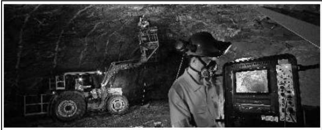
Figura 2.6- Visualização de televisionamento de furo em escavação na mina Cuiabá.
