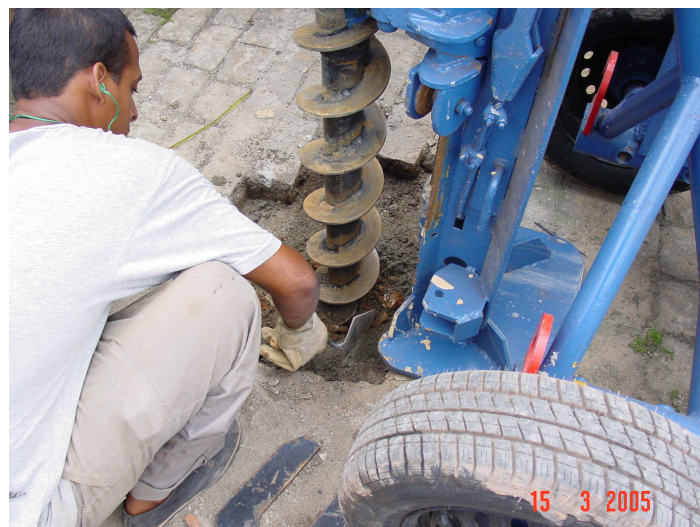
Figura 4.12 – Furo de sondagem sendo perfurado com o auxílio da perfuratriz
