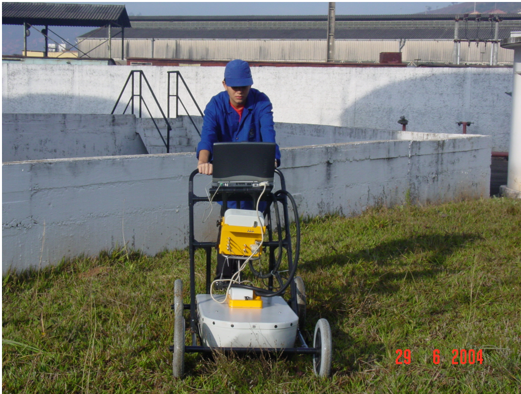
Figura 5.4 – Aquisição com o GPR na base de combustíveis em Santos Dumont-MG
