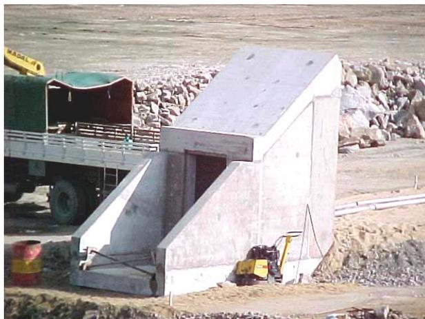
Figura 29 - Cabine de leitura em concreto pré-moldado, concentra os pontos de leitura de caixas suecas e extensômetros horizontais de hastes múltiplas.
