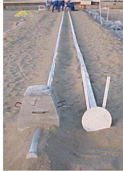
(b) Instalação de uma linha de caixas suecas ao lado de uma linha de extensômetro horizontal de hastes múltiplas
