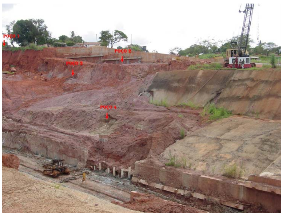
Figura 12- Corte 1, Emboque Sul, LD – Locais de onde foram retirado amostras.
