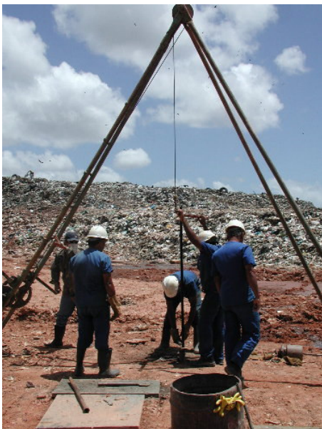
Figura 102 – Equipe realizando ensaio de SPT em RSU.
