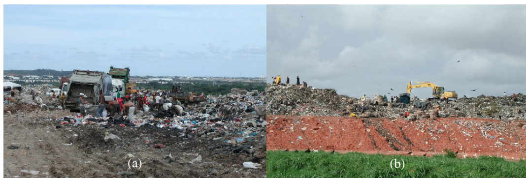
Figura 85 – Fotos do topo da célula 08: (a) catadores na frente de operação; (b) espalhamento na adjacência com célula 04
