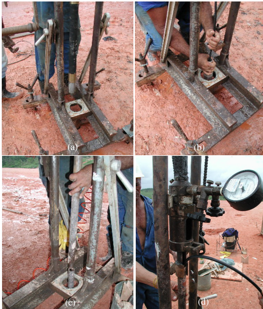
Figura 98 – Fotos da etapa de instalação do pressiômetro: (a) e (b) inserção da sonda; (c) colocação das hastes; (d) cravação do conjunto.
