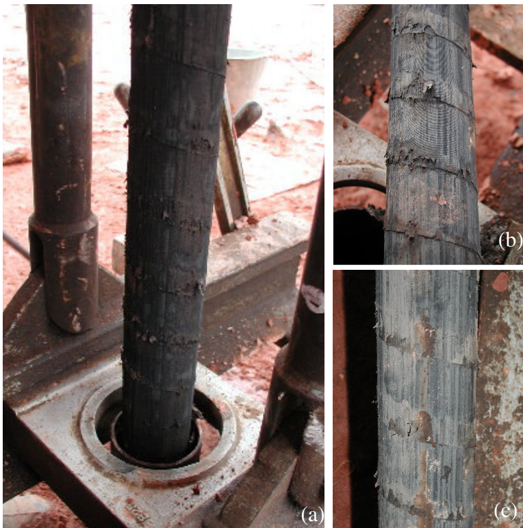
Figura 93 – Detalhes da membrana danificada após cravação direta
