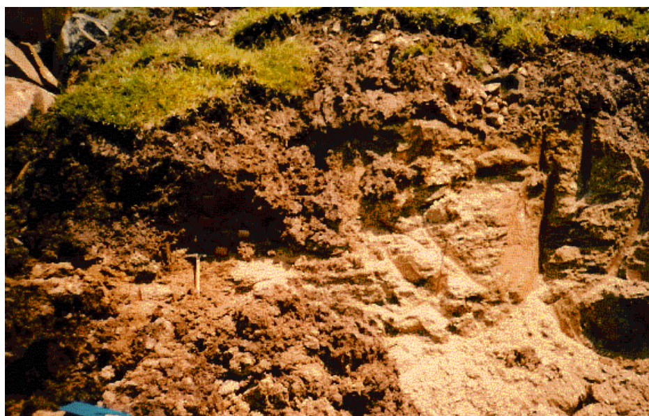
Figura 4.54 Colúvio sobre solo residual (km 1+640, LoteII).
