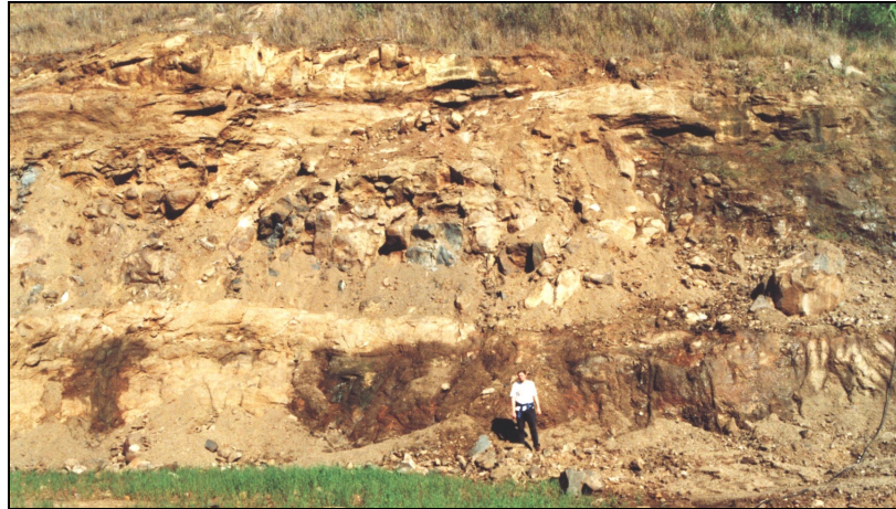
Figura 4.12. Talude do D4 em estado avançado de alteração intempérica, com estruturas de fluxo e alguns blocos de rocha preservada.
