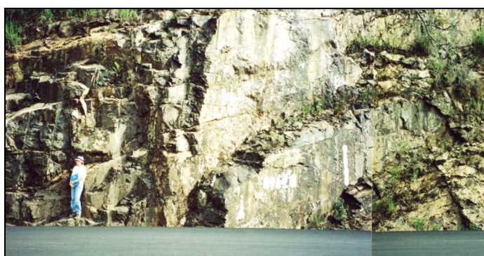
Figura 4.29 Aspecto de campo do talude de corte do D11.
