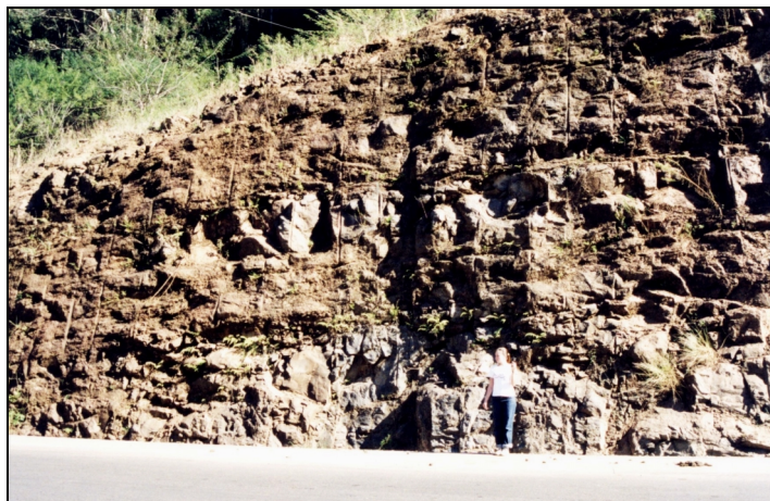
Figura 4.11 Talude do D4 com estruturas de fluxo intercaladas com porções de rocha preservada.
