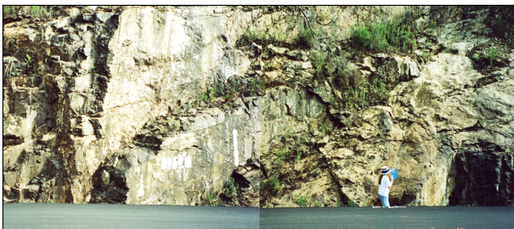
Figura 5.41 Talude do D11 onde ocorreu o escorregamento planar.
