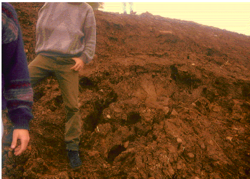
Figura 6.13 Escorregamento rotacional em colúvio gerado por corte de talude (km 1+600 – Lote II).
