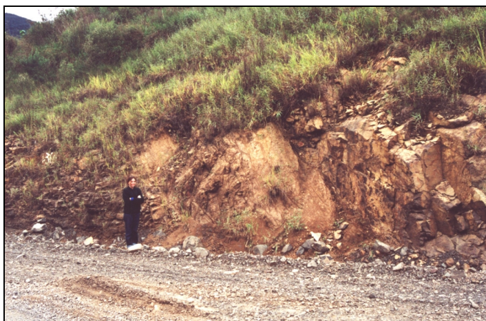
Figura 4.34. Zona de falha E-W no talude do D12.
