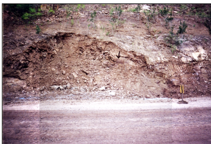
Figura 5.39 Face de ruptura do talude do D4.
