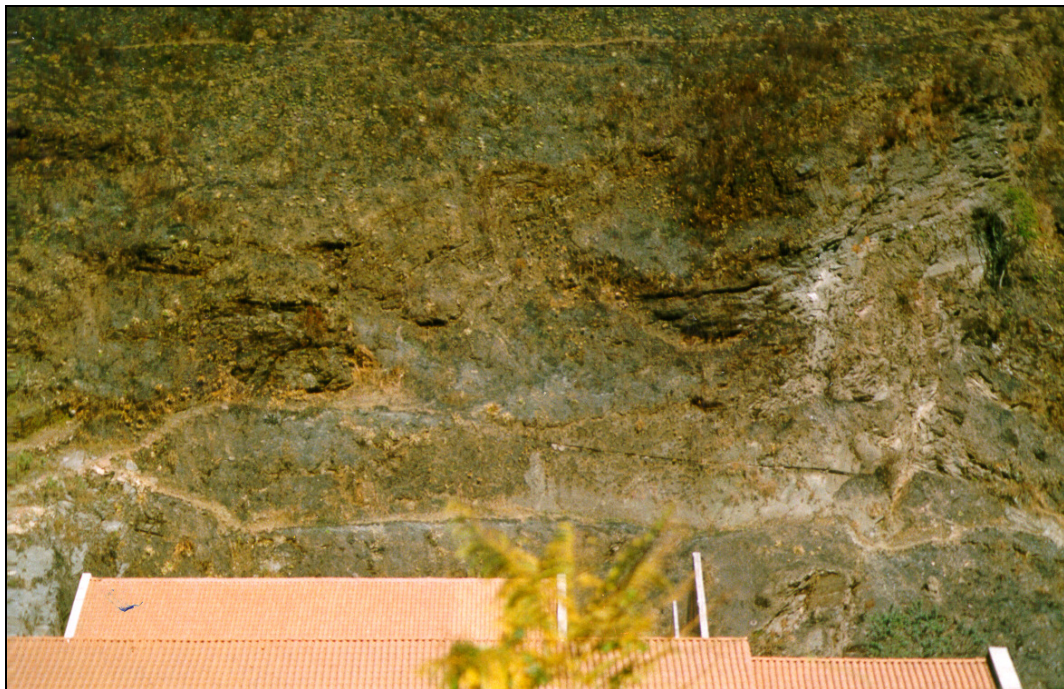
Figura 5.11. Vista geral das famílias de fraturas horizontais no setor 8.
