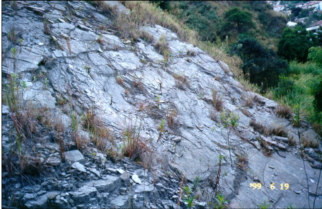
Figura 5.8. Escorregamento, condicionado pelo sistema de descontinuidades da encosta.
