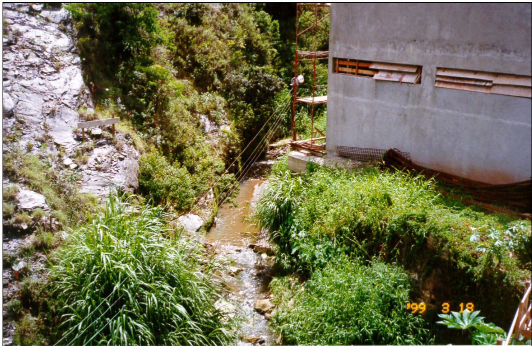
Figura 5.4. Vista parcial da calha de drenagem da encosta do Morro do Curral.
