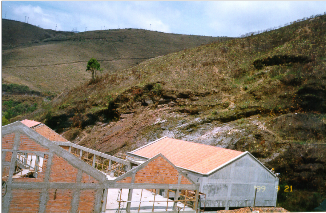
Figura 5.12. Zona geotécnica do agrupamento I setores 1 a 6
