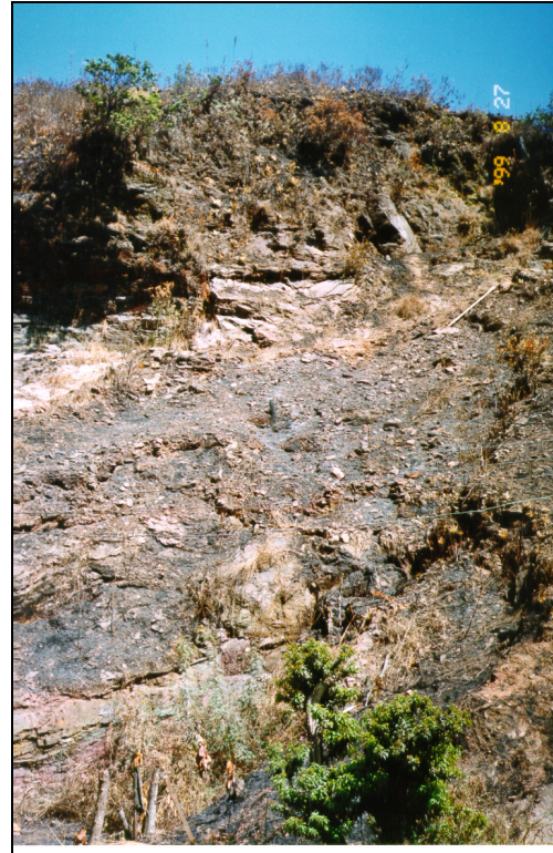
Figura 5.6. Vista da dobra estrutural da Encosta do Morro do Curral.
