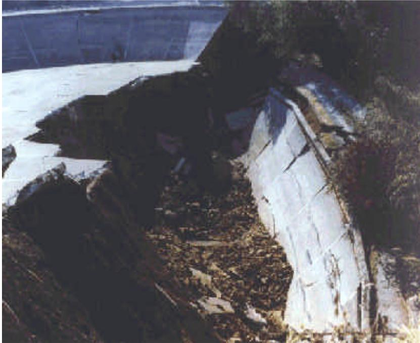
Figura 11 - Ruptura da barragem de Centralia (USBR, 2003)
