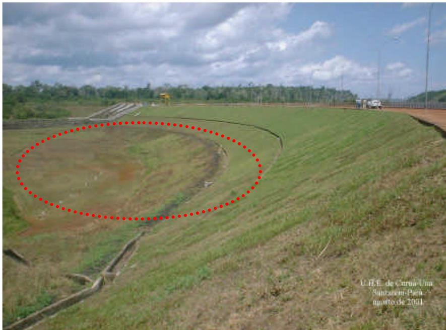
Figura 31 - Vista do Talude de Jusante e Localização dos Piezômetros
