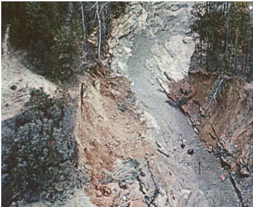
Figura 12 - Ruptura da barragem de Kelle Barnes (USGS, 2003)
