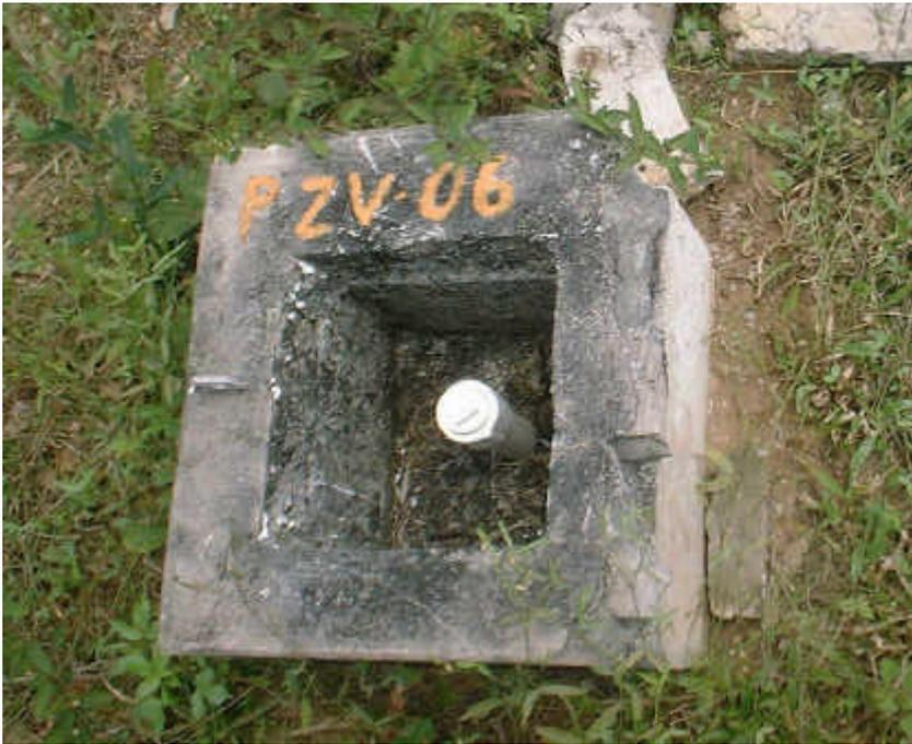
Figura 43 - Piezômetro instalado no vertedor (PZV-06)
