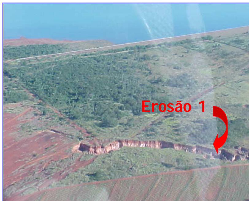
Figura 4.2 – Vista aérea com destaque para Erosão 1
