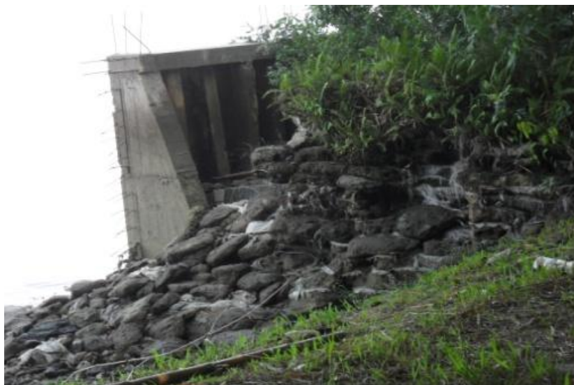
L – Término do muro de contenção em 260NE
