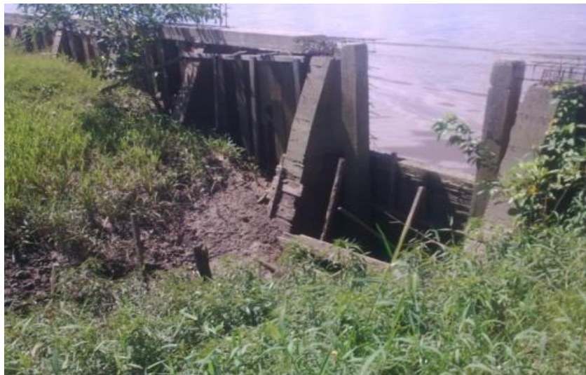
K – Muro de contenção aberto à passagem de água em 240NE:
