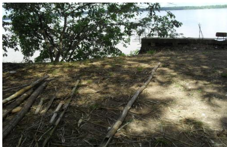
S – Término do muro de contenção até cerca de 490NE.
