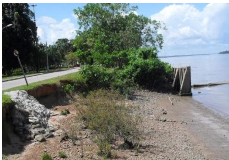
F – Muro de contenção de 150 a 170NE, distante 4,5 m da pista.
