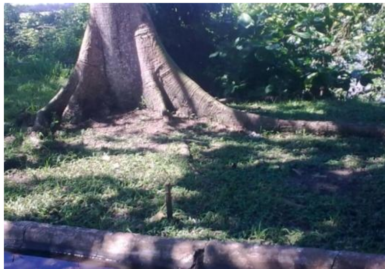
C – Grande árvore aos 90NE, distante 2 m da pista a 1,5 m da erosão.
