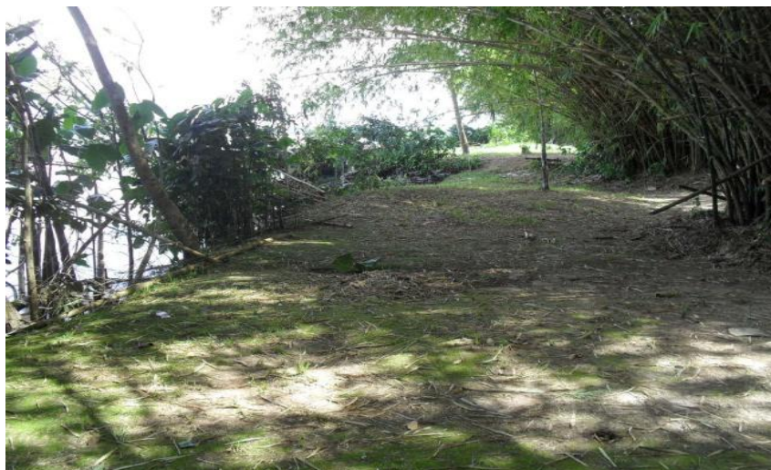
M – Queda do muro de contenção de 260 a 280NE.
