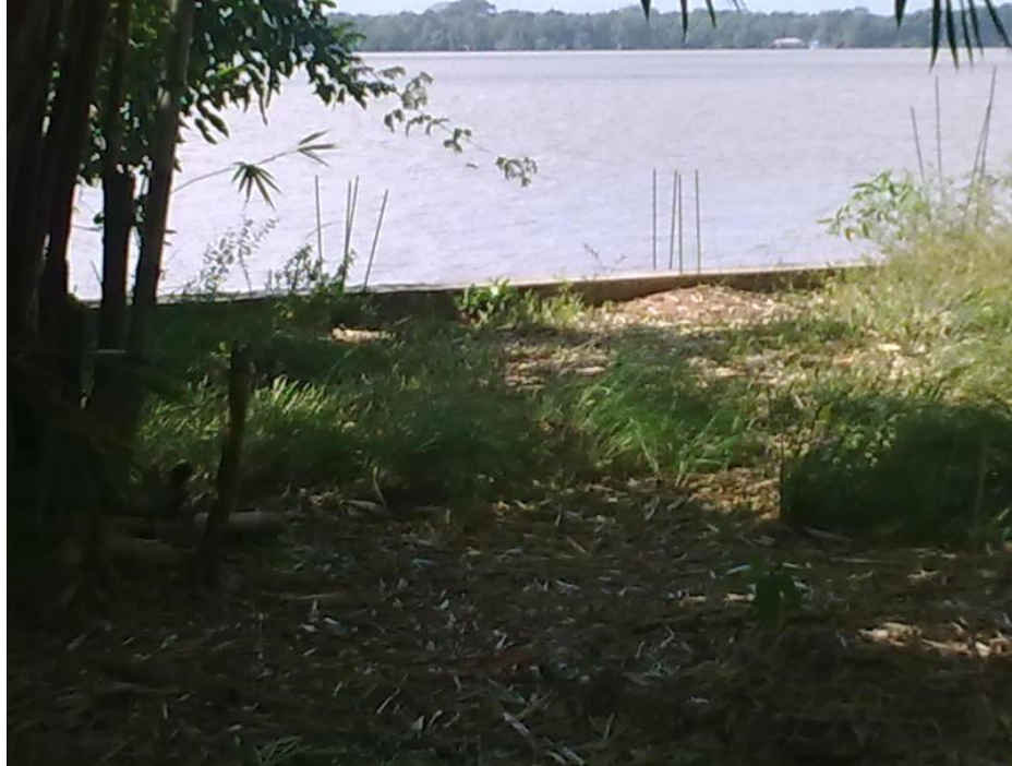
Figura 2.15 Foto mostrando contenção da erosão fluvial com muro de concreto na orla do Campus da UFPA.
