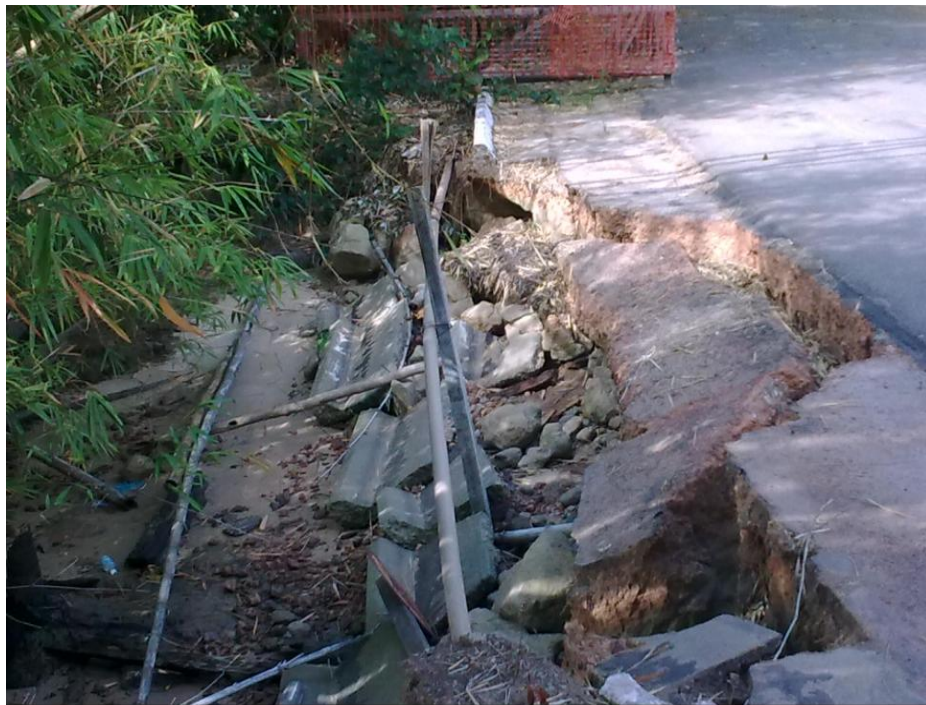
Figura 2.14 Foto revelando o desmoronamento parcial da pista no trecho entre 520 a 540NE, da linha AB identificada na Figura 2.1.
