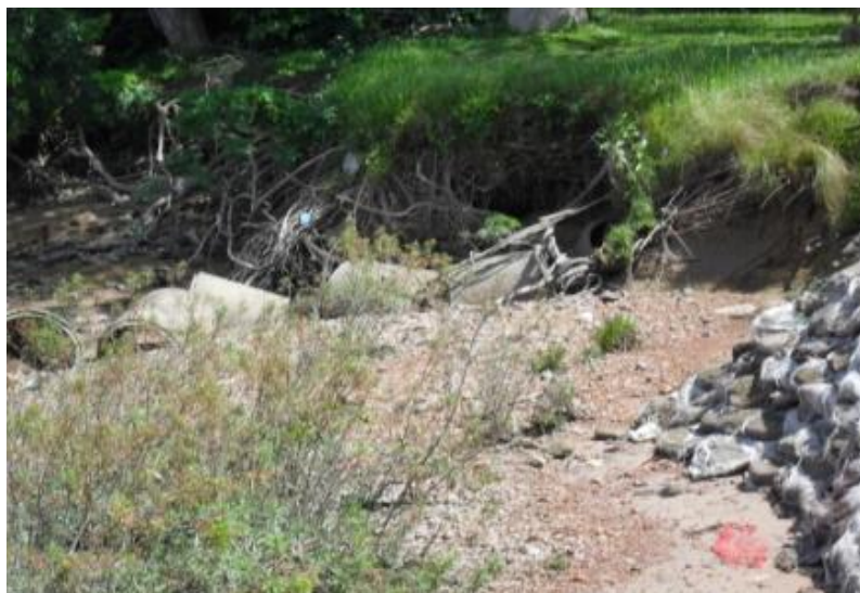
D – Tubulação em 112NE.
