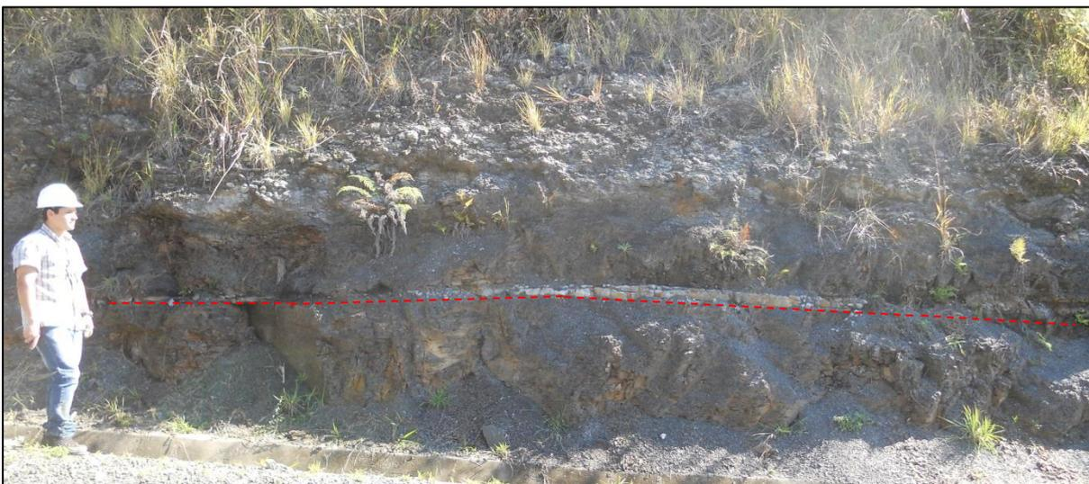
Figura 21: Vista do talude da estrada com camada decimétrica de calcário nas proximidades do acesso à casa de força.
