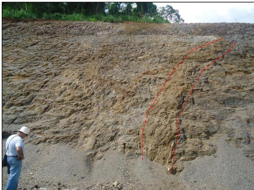
Figura 26: Dique alterado cortando os siltitos da formação Irati em talude próximo a desvio da câmara de carga.
