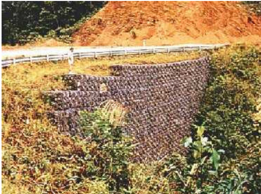
Figura 1 - Trecho da Rodovia com Solo Reforçado na Malásia (Maccaferri, 1997)
