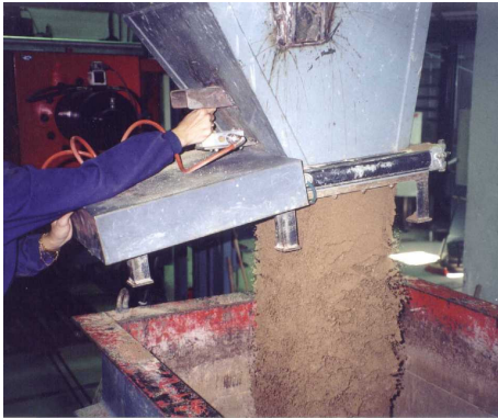
(a) Preenchimento da caixa com solo
