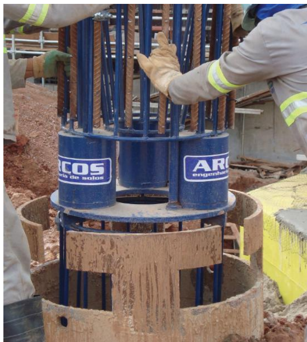
Figura 2.22 – Instalação de três células expansivas em armação de estaca moldada in loco tipo “estacão” (fonte: cedido à pesquisadora).
