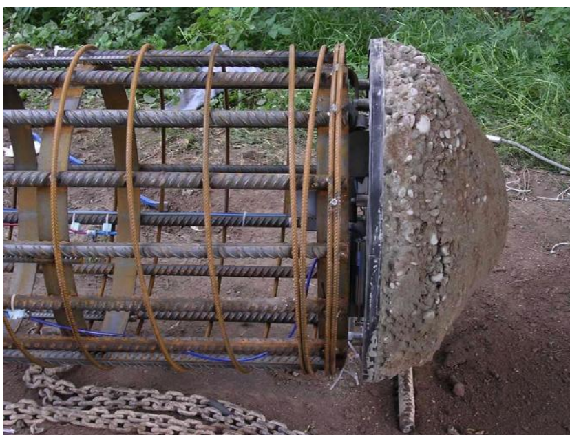
Figura 2.20 – Célula de pressão total, instalada na extremidade inferior da armação da estaca. Observa-se que foi executado um cone de concreto abaixo da célula, para evitar que fiquem vazios sob a ponta da estaca após sua instalação (fonte: GEOKON, 2017).
