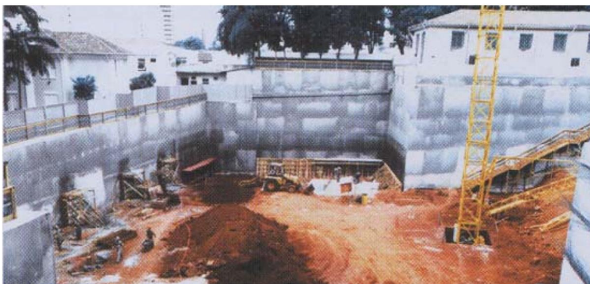
Figura 6– Vista geral da obra do Novo Hospital da Beneficência Portuguesa (Fonte: Pitta et al., 2013).
