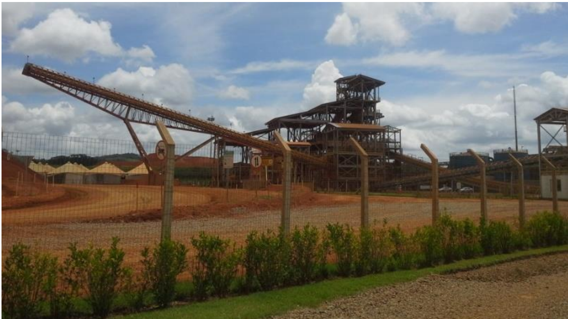
Figura 5-1 – Usina de beneficiamento de minério de bauxita – Unidade Mirai. (Autor, 2016)
