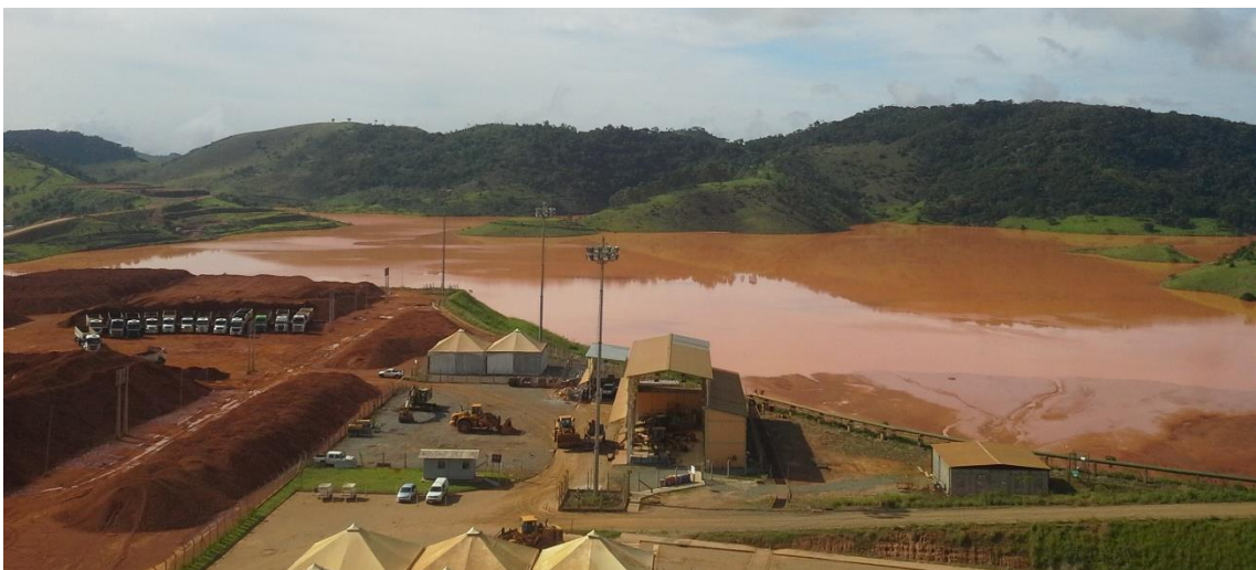
Figura 5-8 – Pilha da bauxita beneficiada e barragem de contenção do rejeito da bauxita lavada - Unidade Mirai (Fonte: Autor, fev./2016).
