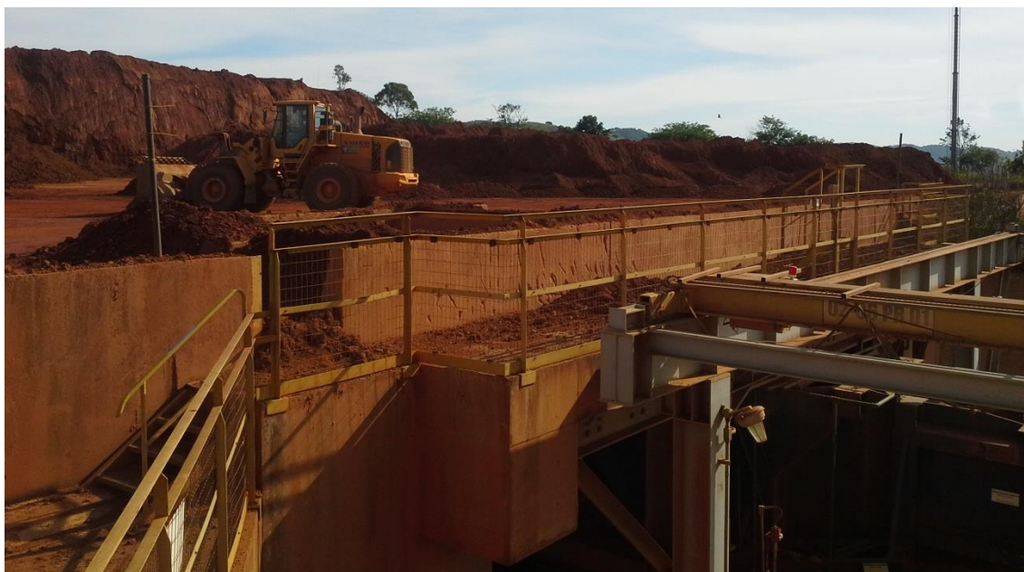
Figura 5-3 – Alimentação da moega com pá carregadeira - Unidade Mirai (Acervo pessoal, fev./2016).
