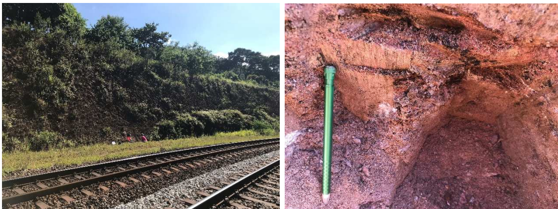
Figura 5.12 – Vista panorâmica do talude do km 524+108 (a esquerda) e em detalhe (a direita)
