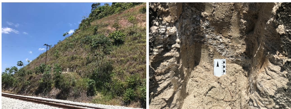
Figura 5.2 – Talude km 482+299, localizado no município de Antônio Dias - MG
