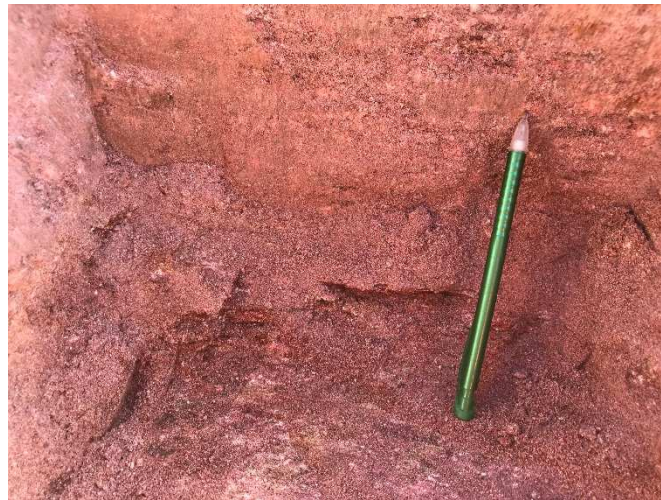
Figura 5.10 – Detalhe do saprólito que constitui o talude do km 521+000
