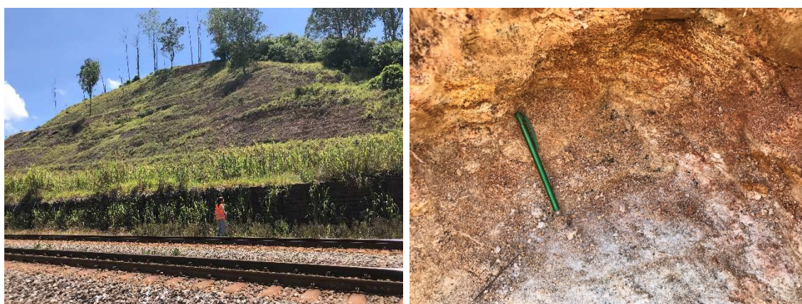
Figura 5.3 – Talude km 493+600 localizado no município de Antônio Dias-MG
