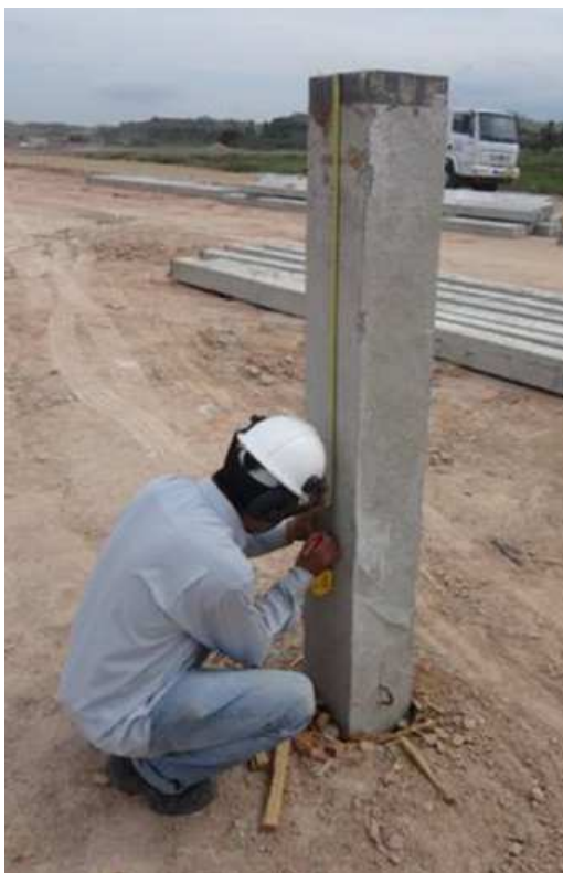
Figura 3 - Marcação da estaca para instalação dos sensores (Fonte: própria do autor)
