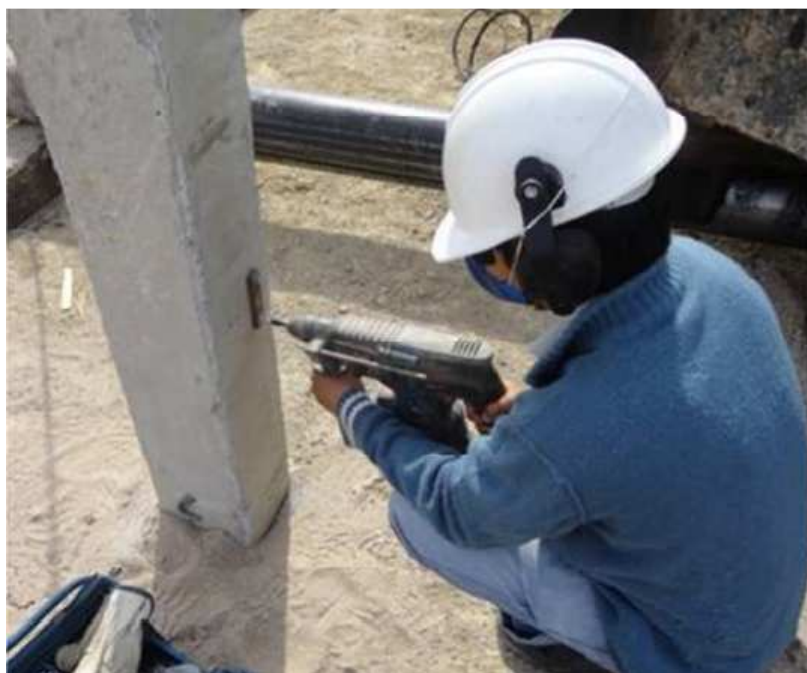
Figura 4 – Furação da estaca para instalação dos chumbadores (Fonte: própria do autor)
