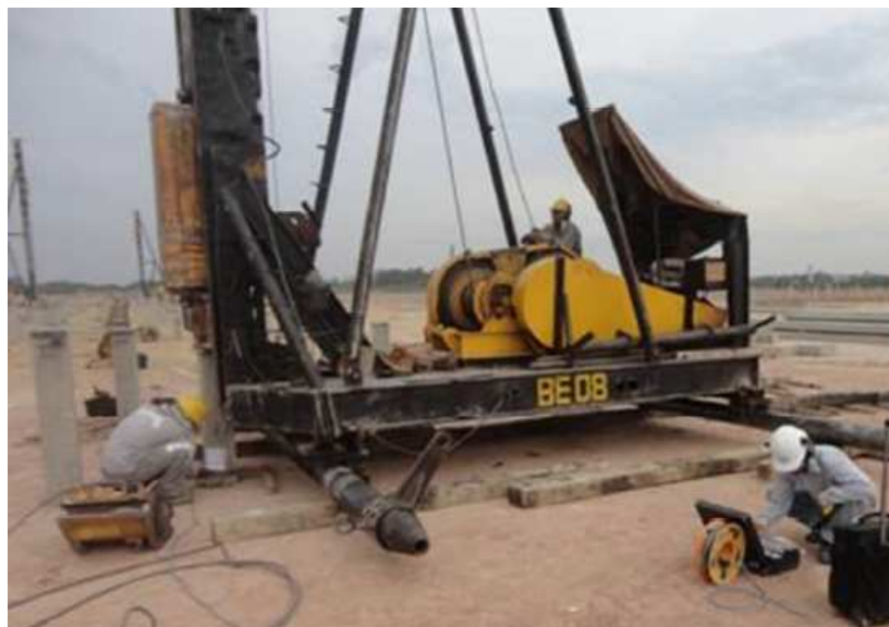
Figura 8 – Aplicação dos golpes do martelo do bate-estaca (Fonte: própria do autor)
