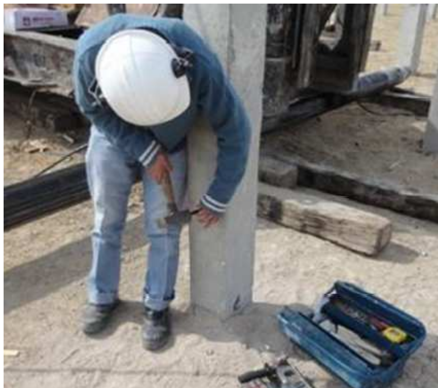
Figura 5 – Instalação dos chumbadores (Fonte: própria do autor)
