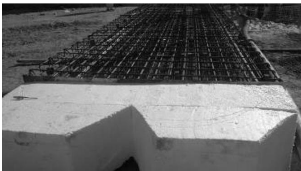
Figura 62 - Bloco de isopor EPS na parte inferior da armadura.
