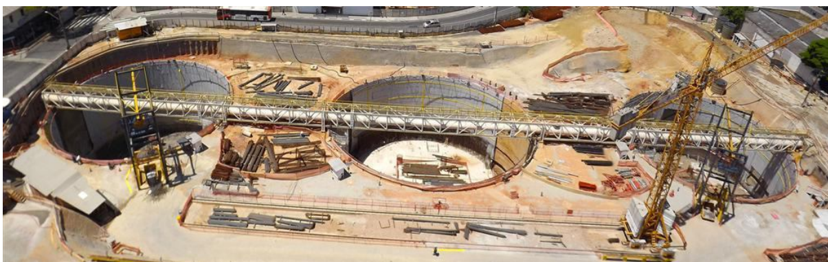
Figura 20 Construção da Estação Adolfo Pinheiro da Linha 5 (Lilás). Hugo Rocha (13)
