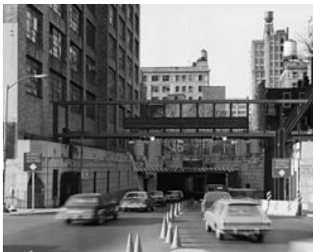
Figura 6 Foto da entrada do túnel Holland, Manhattan
