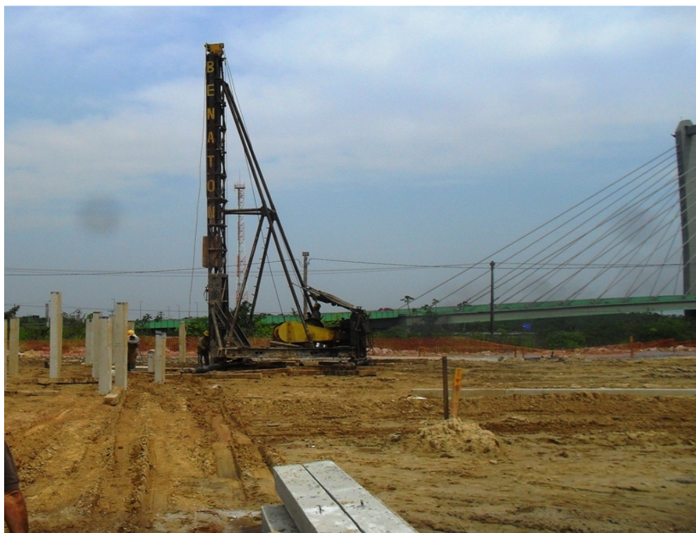
Figura 16 – Bate estacas executando a cravação das estacas (Quadra I)
