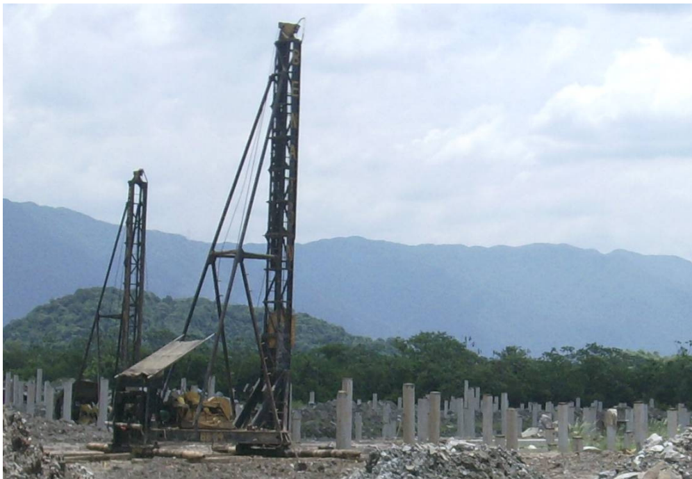
Figura 18 – Panorama das estacas executadas (Quadra N)
