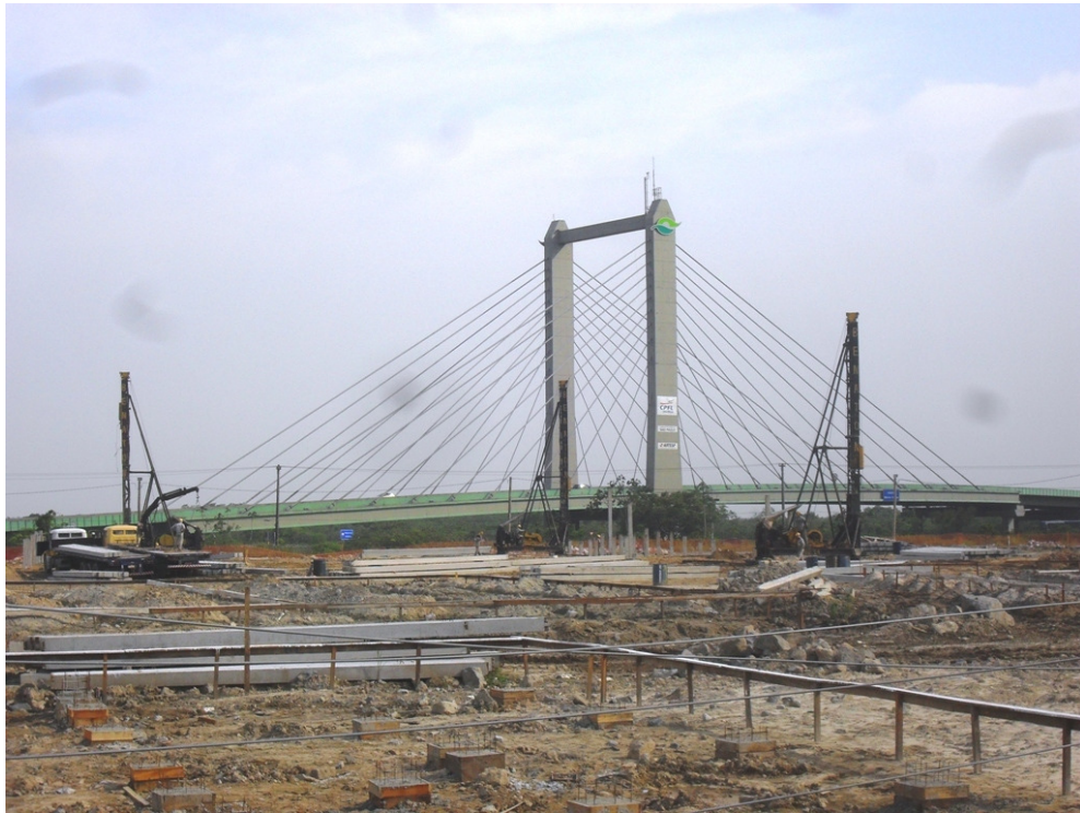
Figura 17 – Panorama da obra (Quadra I)
