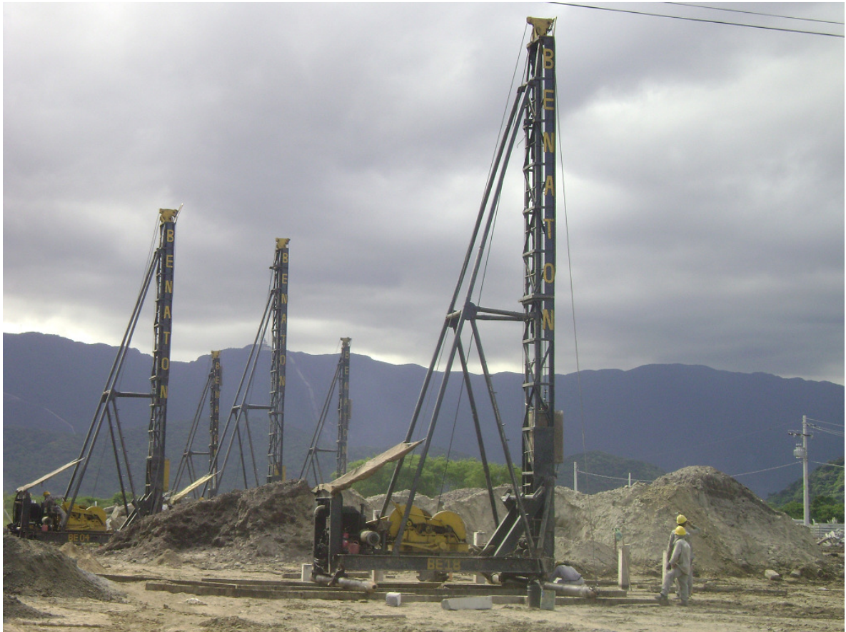
Figura 20 – Panorama dos bate estacas na obra.
