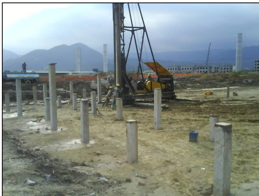
Figura 15 – Bate estacas executando a cravação das estacas.
