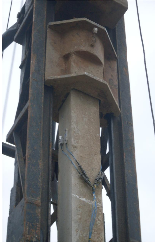
Figura 19 – Sensores de aceleração e deformação instalados na estaca para realização do ensaio de carregamento dinâmico.
