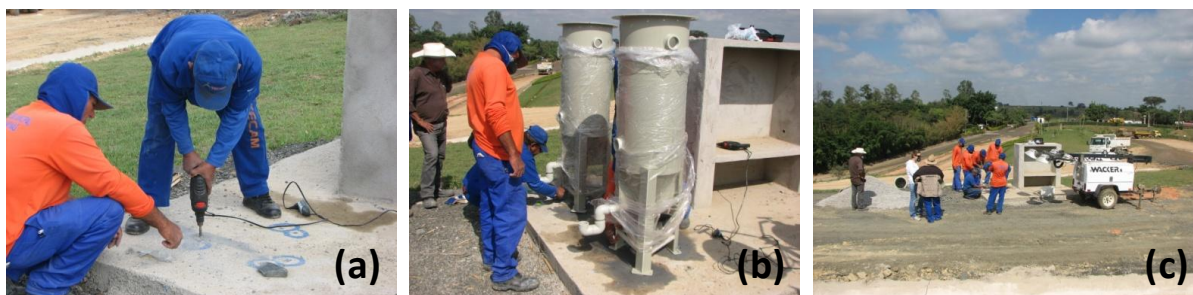
Figura 22 Fixação dos tanques na plataforma
