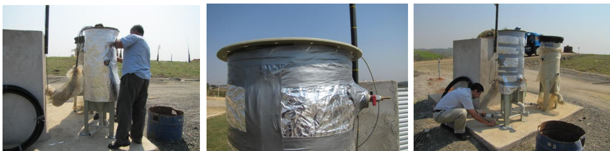
Figura 25 Instalação da manta para isolamento térmico
