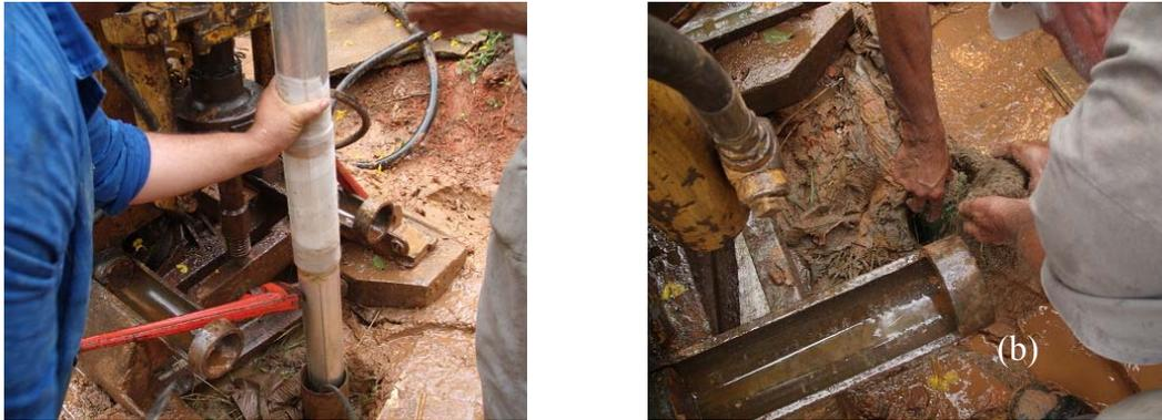
**Figura 4.17** Detalhes da instalação dos inclinômetros
