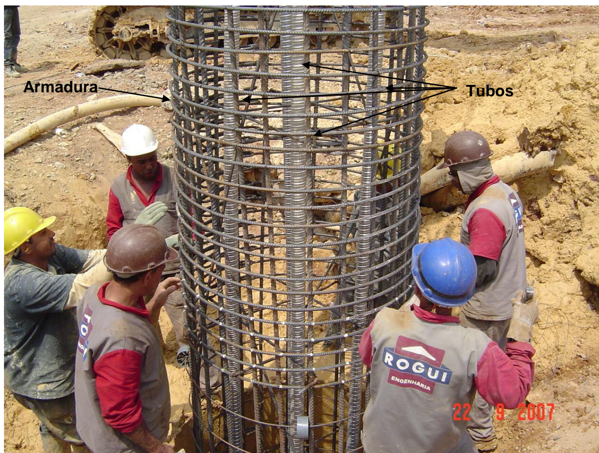
Figura 3.7 – Tubos para passagem das Barras Instrumentadas.
