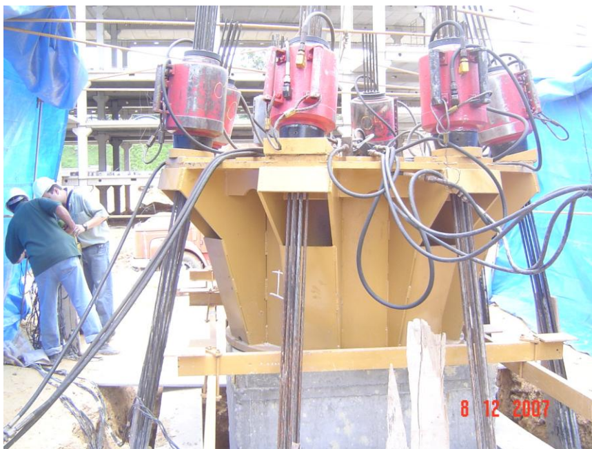
Figura 3.2 – Sistema de Reação da Prova de Carga.
