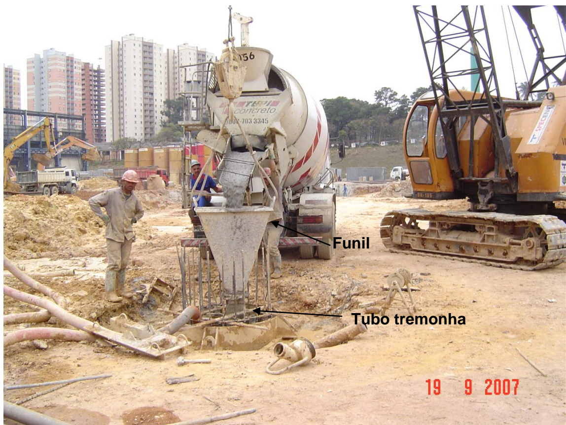
Figura 2.3 – Concretagem do estação.
