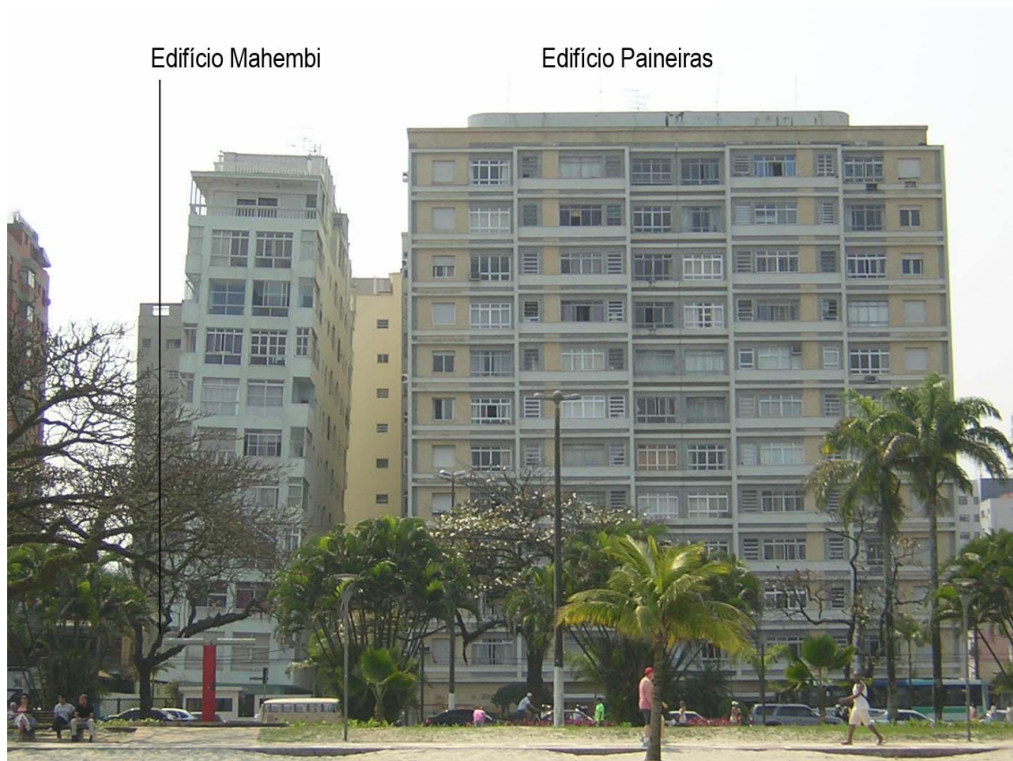
Foto 07 – Edifício Maembi a esquerda da foto, inclinado em direção ao edifício Paineiras, à direita
