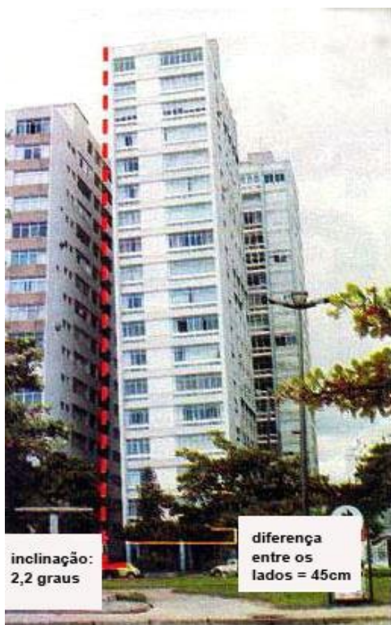
Foto 8(a) Edifício antes do reaprumo
