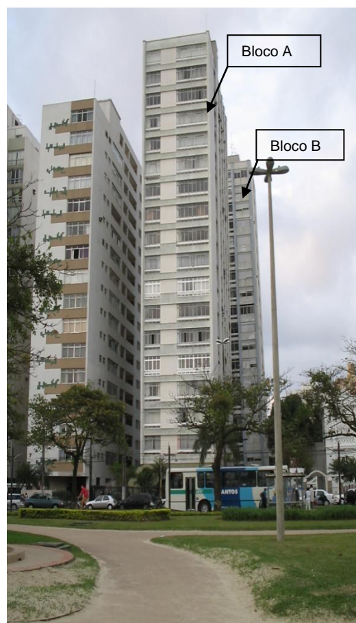
Foto 8(b) Edifício depois do reaprumo
