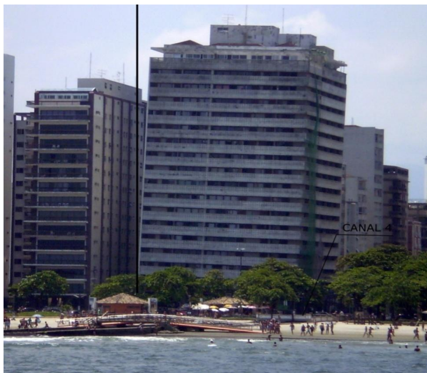
Foto 09 – Edifício Excelsior inclinado para o lado do canal 4
