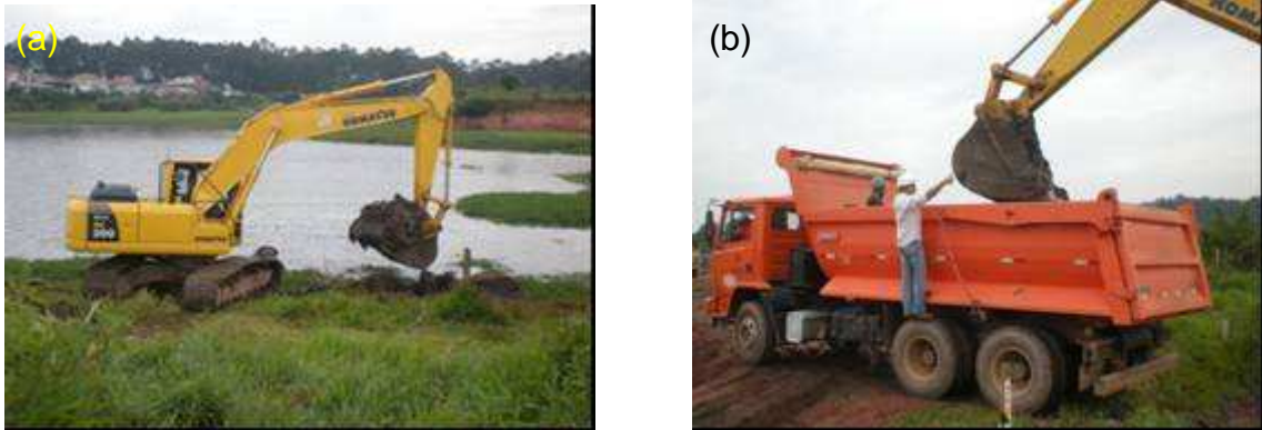
Figura 6.11 - Extração das amostras naturais (a) extração e (b) estocagem
