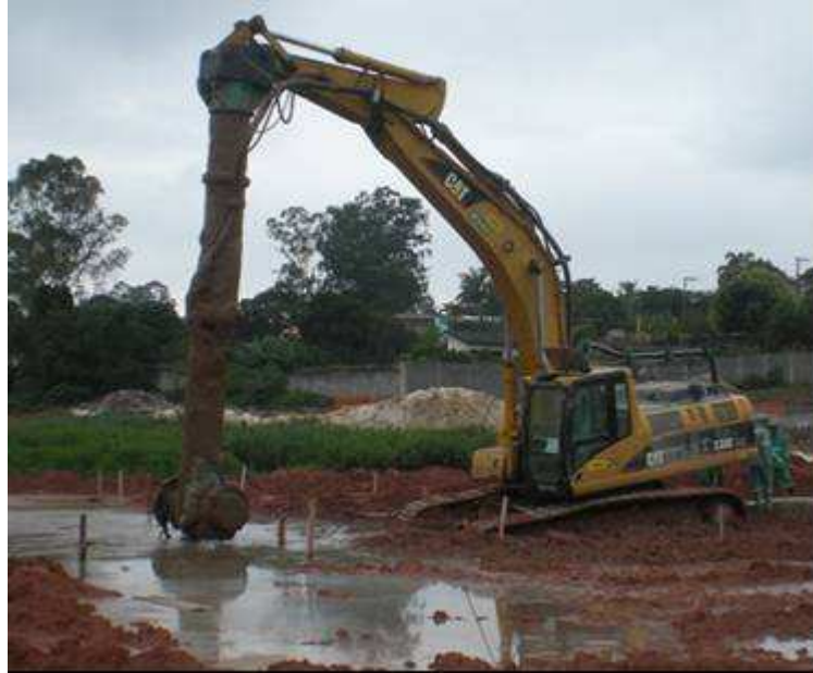
Figura 4.10 - Escavadeira e Multimisturador acoplados e em atividade
