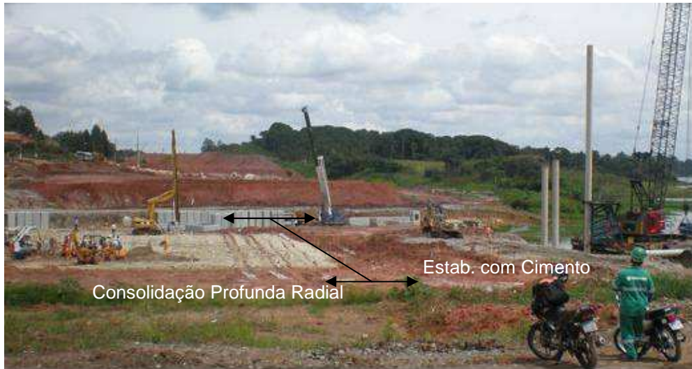
Figura 4.3 - Separação em campo dos trechos tratados com as duas novas soluções
