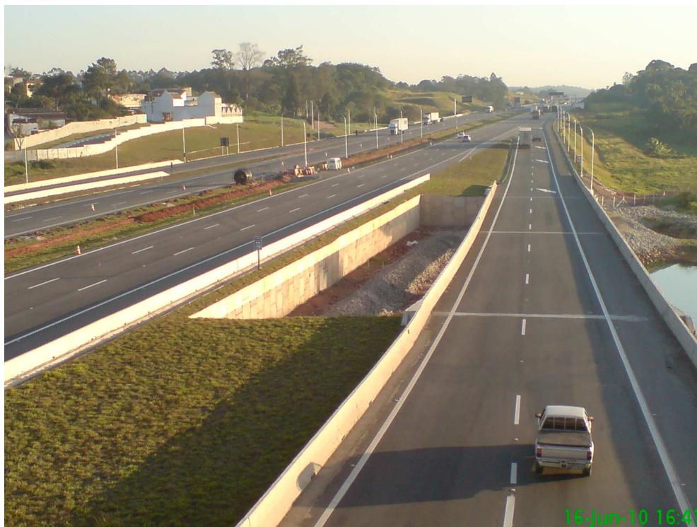
Figura 6.17 - Detalhe da OAE 305 e da pista tratada com a Mistura Mecânica com Aglomerado Cimentício.
