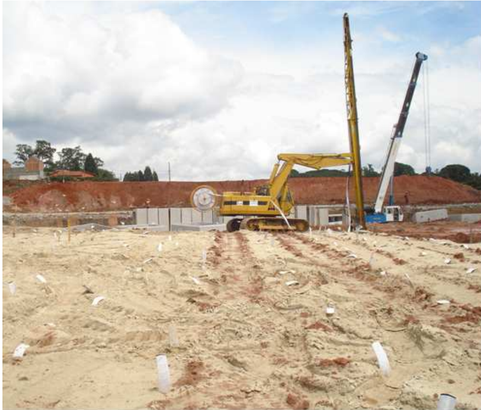
Figura 4.6 - Cravação da malha de drenos verticais
