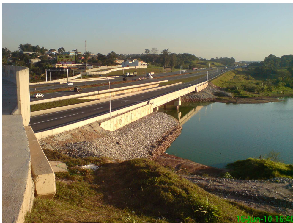
Figura 6.16 - Vista da região do BSM 305 com a obra finalizada.
