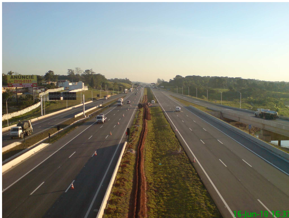
Figura 6.15 - Região do BSM 305 em operação. Pista a direita sob camada tratada com a Mistura Mecânica com Aglomerante Cimentício e do canteiro central para a esquerda solução do CPR.
