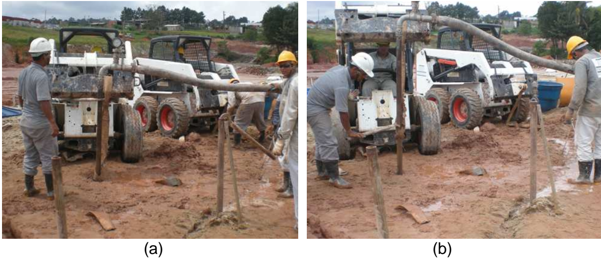
Figura 4.8 - Bombeamento do bulbo na (a) cota inferior e (b) na próxima posição vertical
