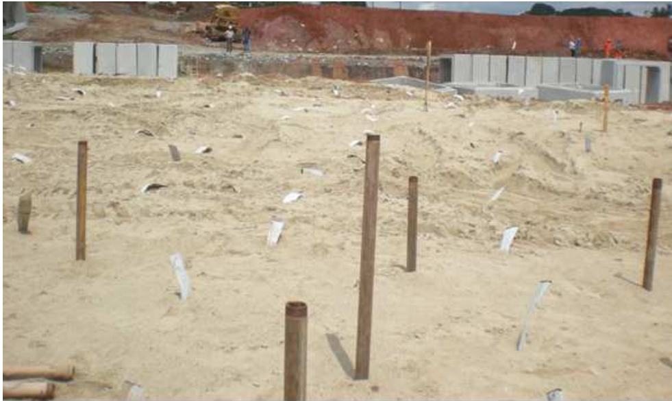
Figura 4.7 - Tubos guias cravados entre a malha de geodrenos
