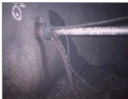
Figura 2.2 – Retorno do refluxo, garantido através de revestimento do furo (túnel da Avenida Santo Amaro com Avenida Juscelino Kubitchek, São Paulo) (Novatecna, 2002)
