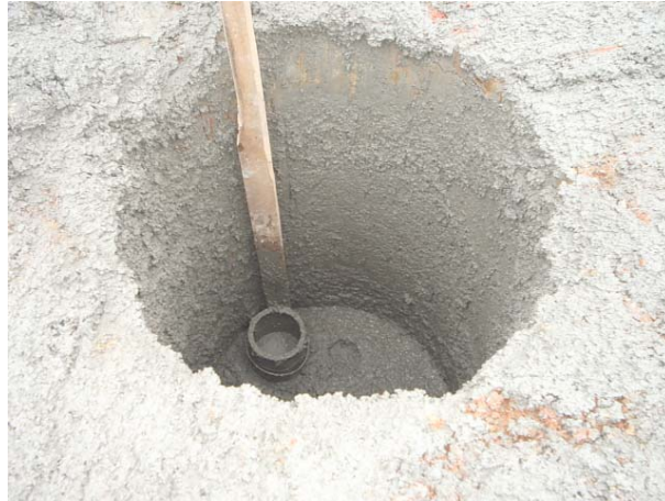
Foto 2.12 – Remoção do concreto ainda fresco.
