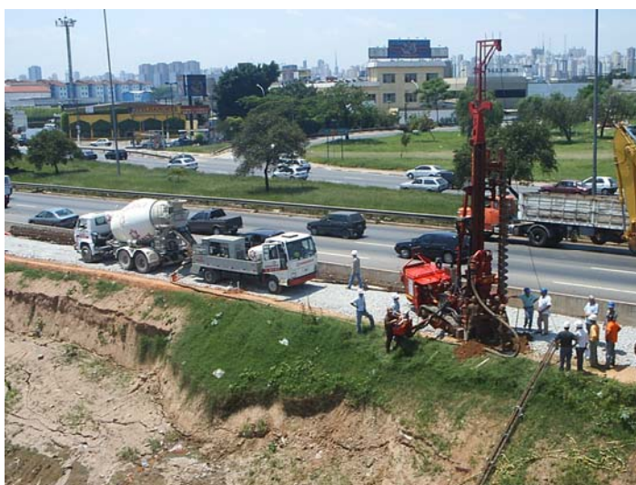
Foto 3.15 – Estacas executadas na margem do Rio Tietê (ENGESTRAUSS, 2004).
