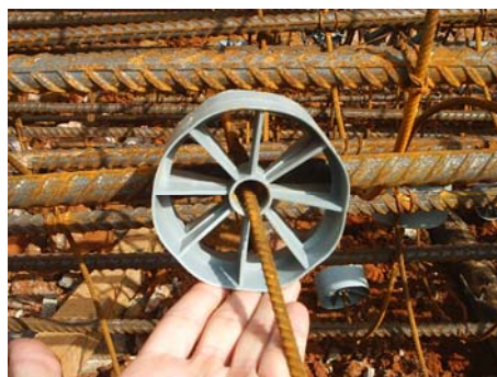
Foto 3.9 – Detalhe do rolete espaçador de plástico.
