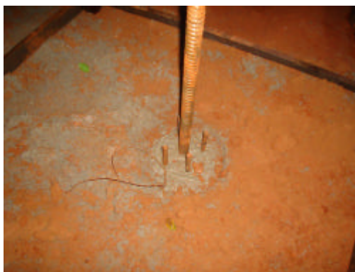
Foto 4.15 – Instalação do tirante imediatamente após a concretagem da estaca.
