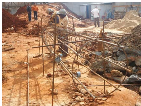
Foto 2.11 – Detalhe das armaduras em forma de gaiola.
