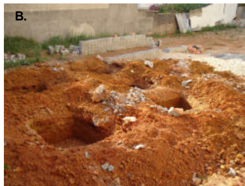
Fotos 4.10 A e B – Regiões de execução dos ensaios de integridade (PIT).
