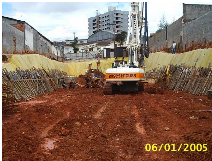
Foto 3.12 – Estacas executadas junto às divisas (ENGESTRAUSS, 2005).
