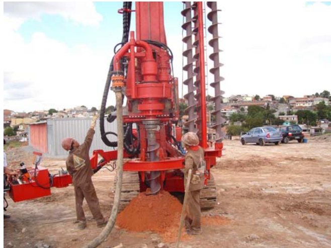
Foto 3.2 – Equipamento SD 45 – Introdução do 1ª segmento da hélice (ENGESTRAUSS, 2006).
