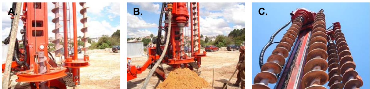
Fotos 3.6 A, B e C – Detalhe do acoplamento da hélice, introdução da hélice subsequente e detalhe do alimentador mecânico de trados (ENGESTRAUSS, 2006).
