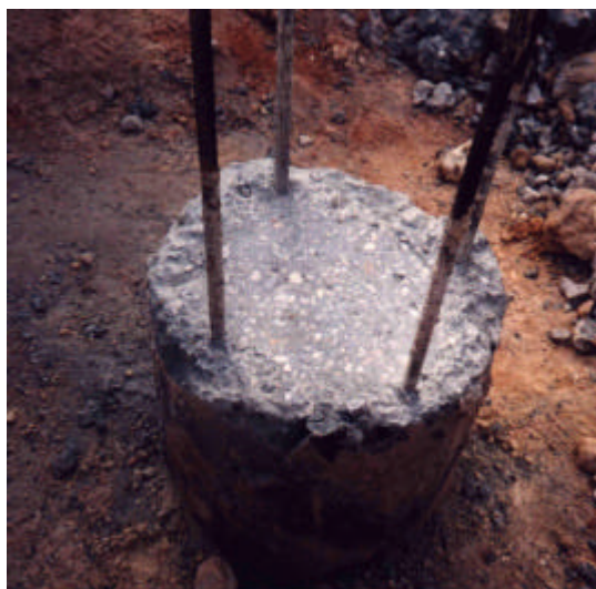
Foto 4.3 – Estaca com a superfície preparada para o ensaio (PDI, 2007).
