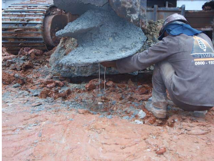
Foto 2.8 – Posicionamento do eixo da hélice no ponto de locação.
