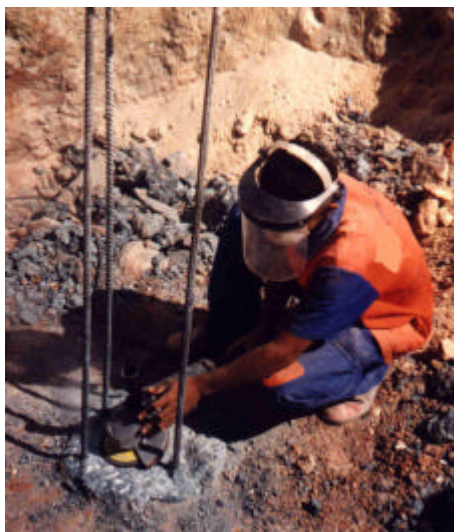
Foto 4.2 – Trabalho para regularização da superfície da estaca (PDI, 2007).
