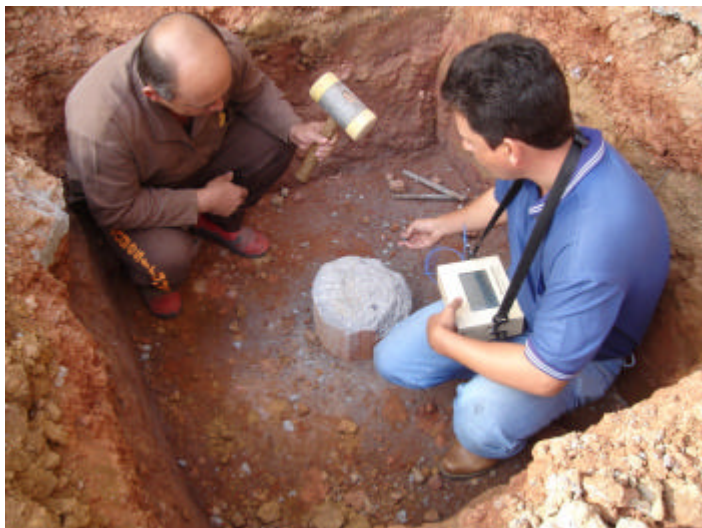
Foto 4.9 – Execução dos ensaios de integridade (PIT).
