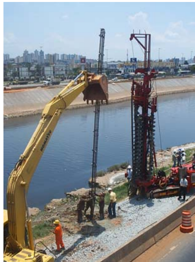
Foto 3.8 – Colocação da armação com auxílio mecânico (ENGESTRAUSS, 2004).
