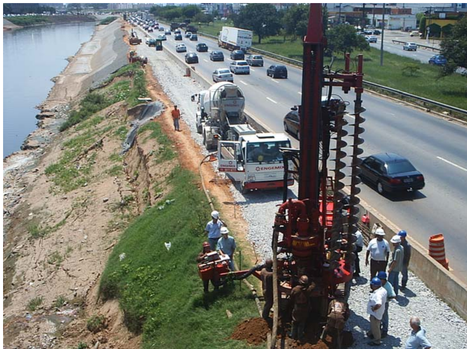
Foto 3.7 – Concretagem da estaca (ENGESTRAUSS, 2004).
