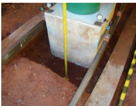
Foto 4.23 – Escavação ao redor do bloco de coroamento.
