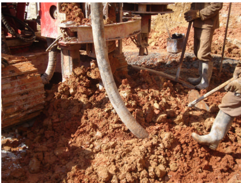
Foto 4.7 – Estacas executadas na região da sondagem SP-04.
