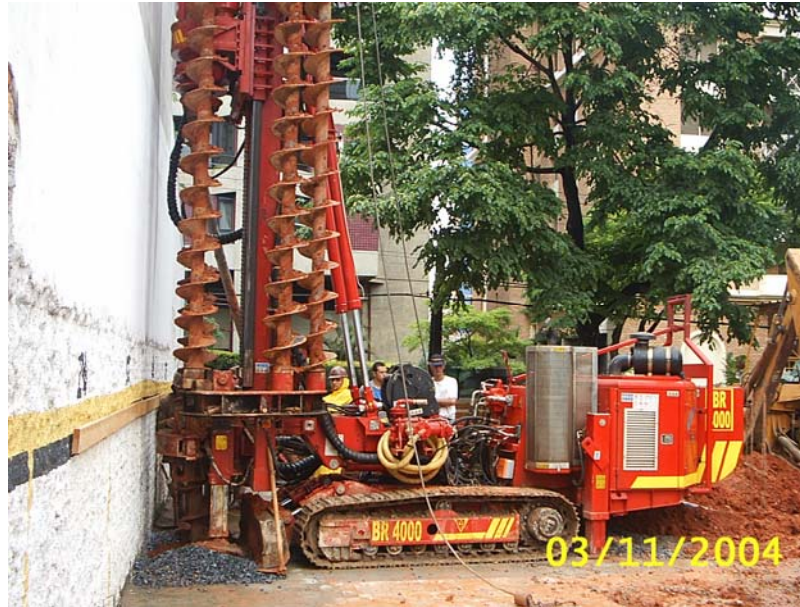
Foto 3.11 – Execução de estaca próxima à divisa (ENGESTRAUSS, 2004).
