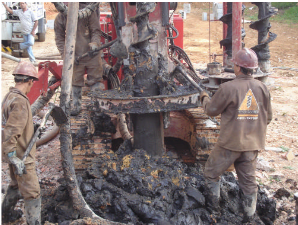
Foto 4.6 – Estacas executadas na região da sondagem SP-01.
