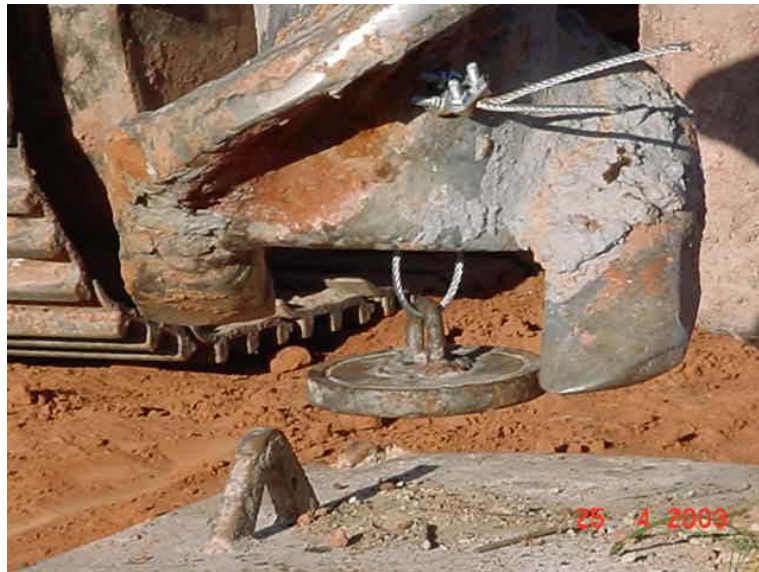
Foto 2.9 – Detalhe da ponta do trado com a tampa recuperável.
