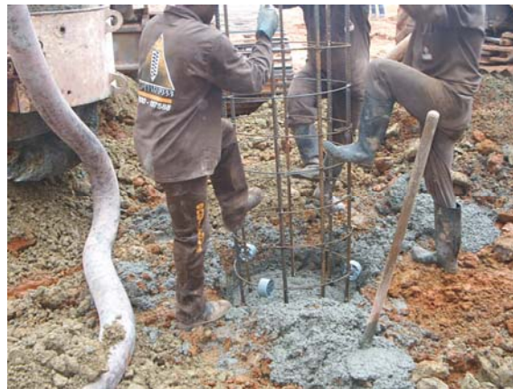
Foto 2.10 – Colocação da armadura manualmente com o auxílio do guincho auxiliar do equipamento.
