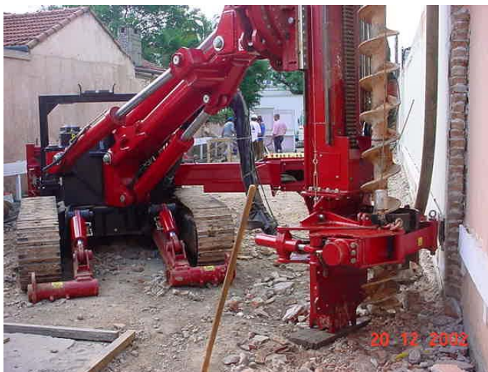
Foto 3.14 – Estacas executadas em locais de espaços reduzidos (ENGESTRAUSS, 2002).
