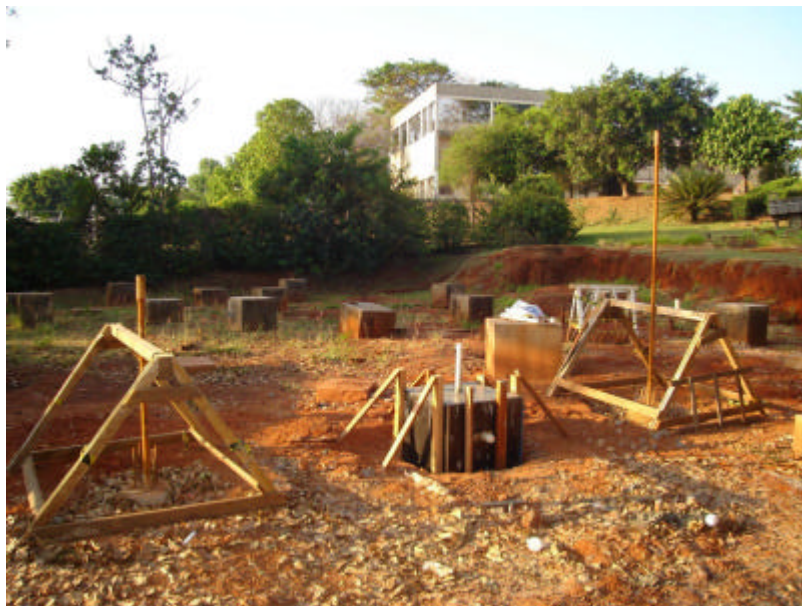
Foto 4.13 – Vista do bloco de coroamento.
