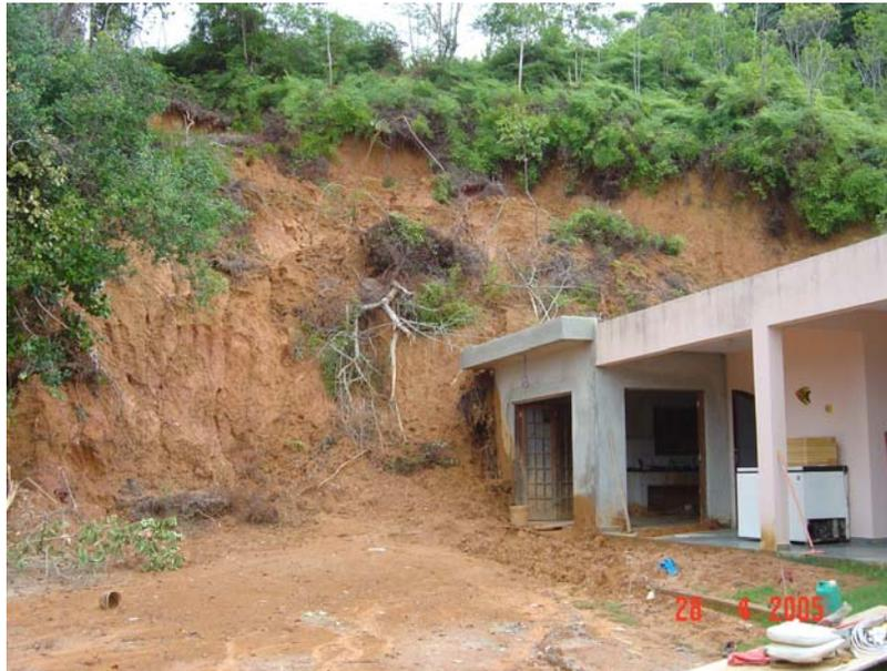
FIGURA 3.13 – ESCORREGAMENTO EM TALUDE DE CORTE (FONTE: ACERVO IG-SMA).
