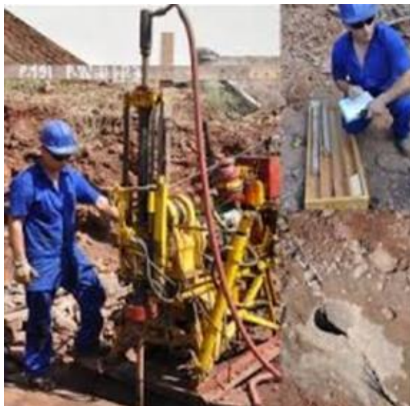
Figura 4.4 – Equipamento de perfuração e testemunhos
