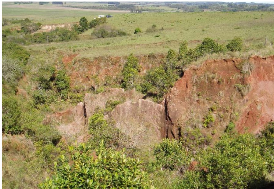
Figura 4.8 – Falhas na voçoroca de São Valentim
