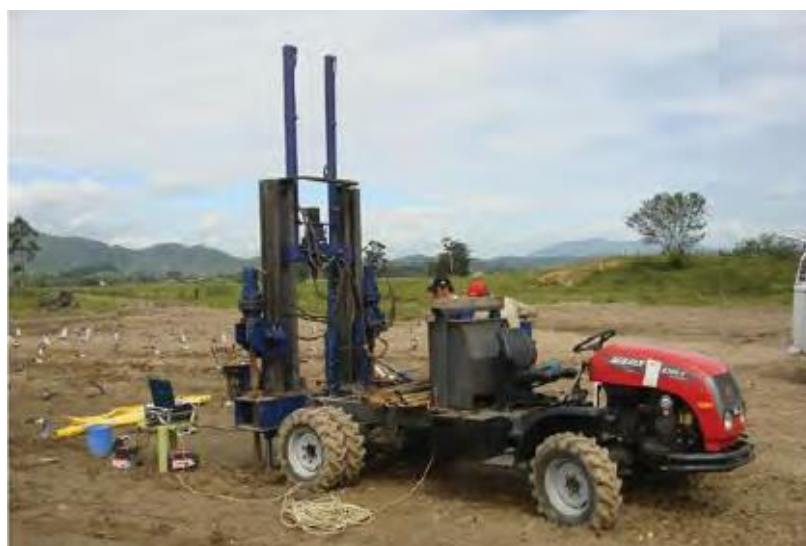
Figura 5 - Sistema de cravação completo
