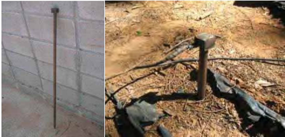
Figura 43 - Barra de aço cravada no solo servindo para aterramento.
