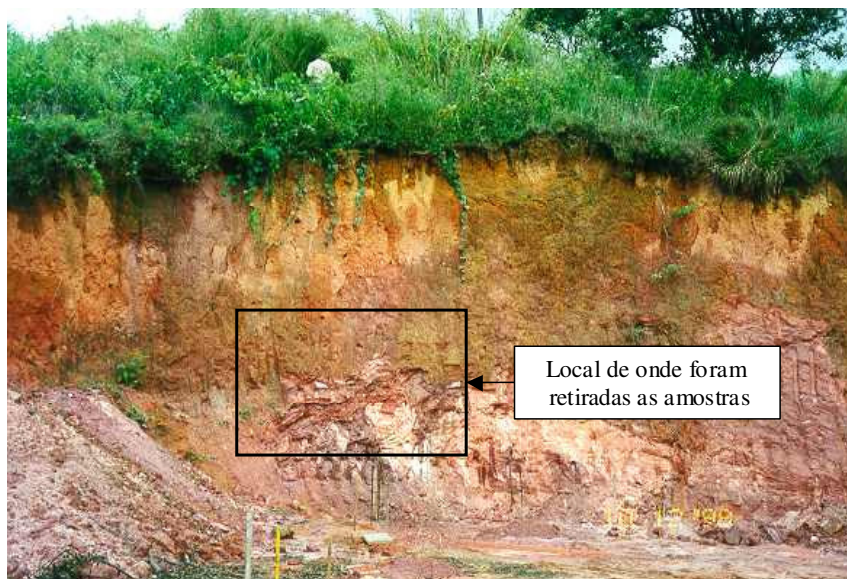
Figura 4.1 - Visão geral do talude de onde foram retiradas as amostras de solo utilizada nesta pesquisa.
