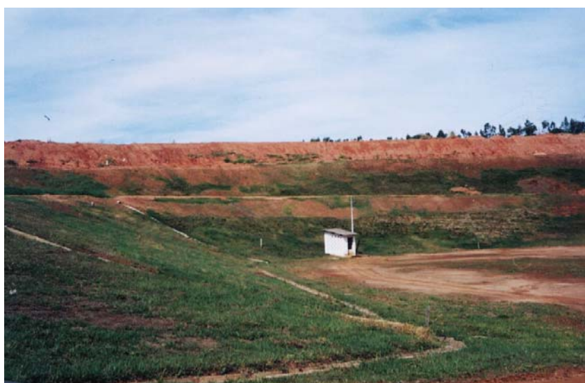
Foto 3.25. Localização da caixa de armazenamento e recirculação do chorume, à jusante do aterro de resíduos sólidos de Bauru.
