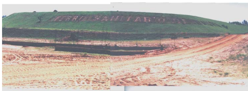
Foto 3.4. Vista geral do aterro de resíduos sólidos de Bauru (EMDURB, 2002).
