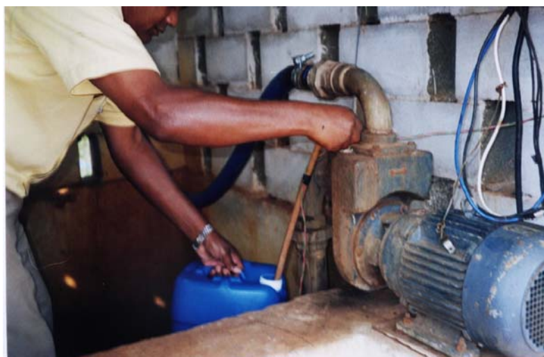
Foto 3.26. Detalhe do momento da coleta do chorume na caixa de armazenamento e recirculação.
