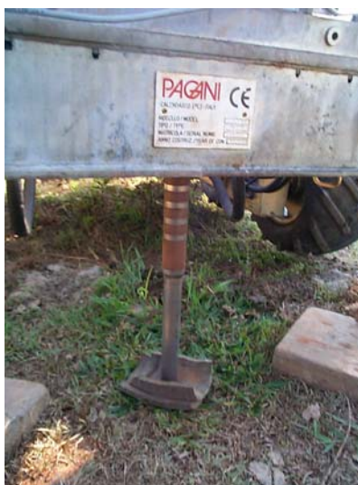
Foto 3.17. Sondagem com piezocone de resistividade sendo realizada na área do aterro de resíduos sólidos de Bauru.
