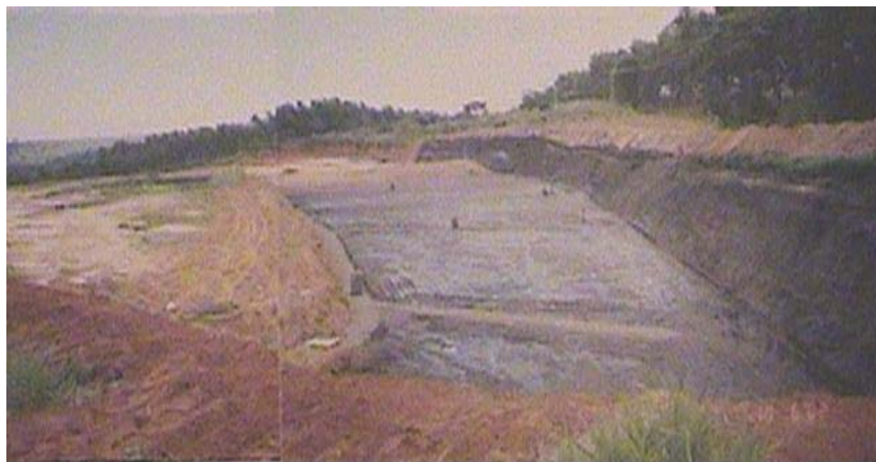
Foto 3.5. Impermeabilização da base do aterro de resíduos sólidos de Bauru feita com CM-30 diluído (EMDURB, 2002).
