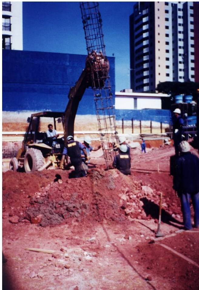
Foto 2.2 – colocação da armadura com auxílio de retro-escavadeira
