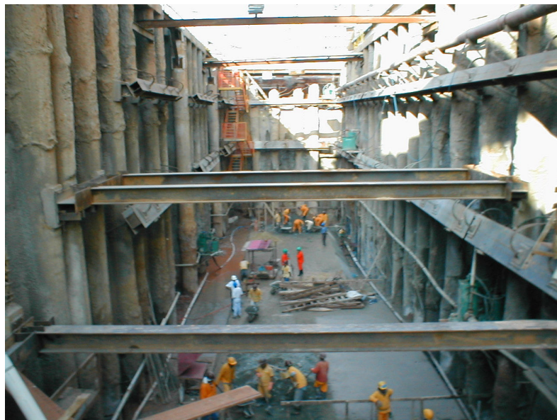
Foto 3.7 – vala já escavada e estroncada.
