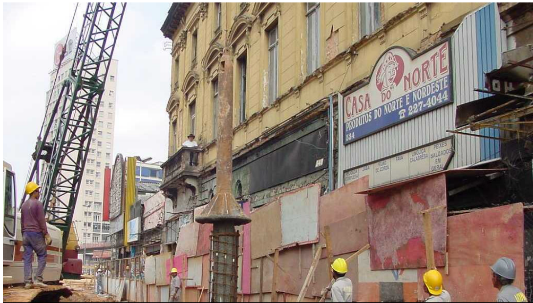
Foto 3.3 – cravação da armadura com auxílio de pilão.
