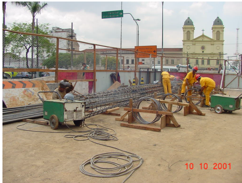
Foto 3.2 – montagem das armaduras
