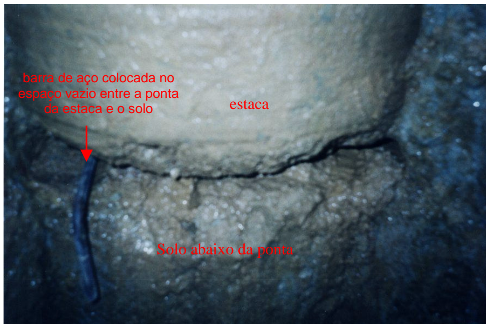
Foto 2.7 - detalhe da ponta de uma estaca hélice contínua executada em solo argiloso (SOUZA, 2001).
