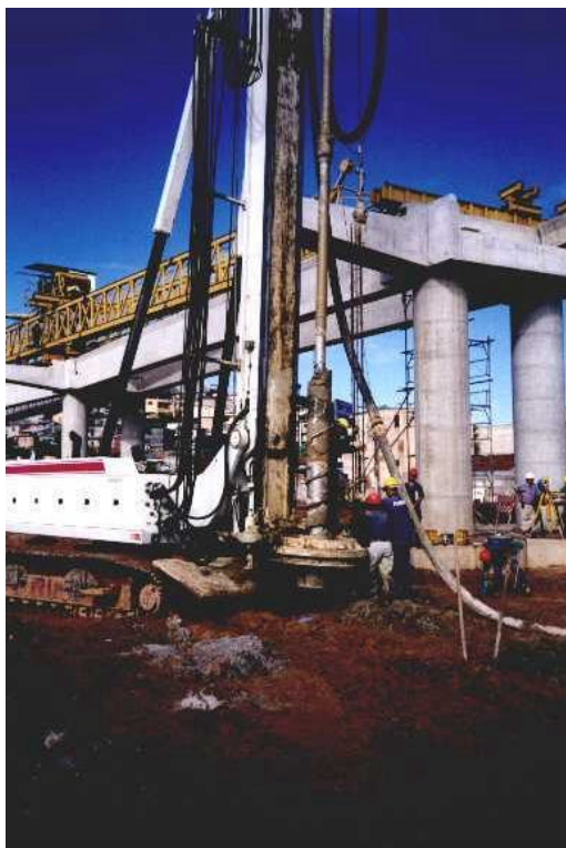
Foto 3.1 – execução de uma estaca no local e ao fundo a via elevada.
