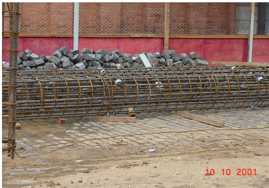
Foto 2.4 - armação de estaca hélice contínua executada na estação Luz
