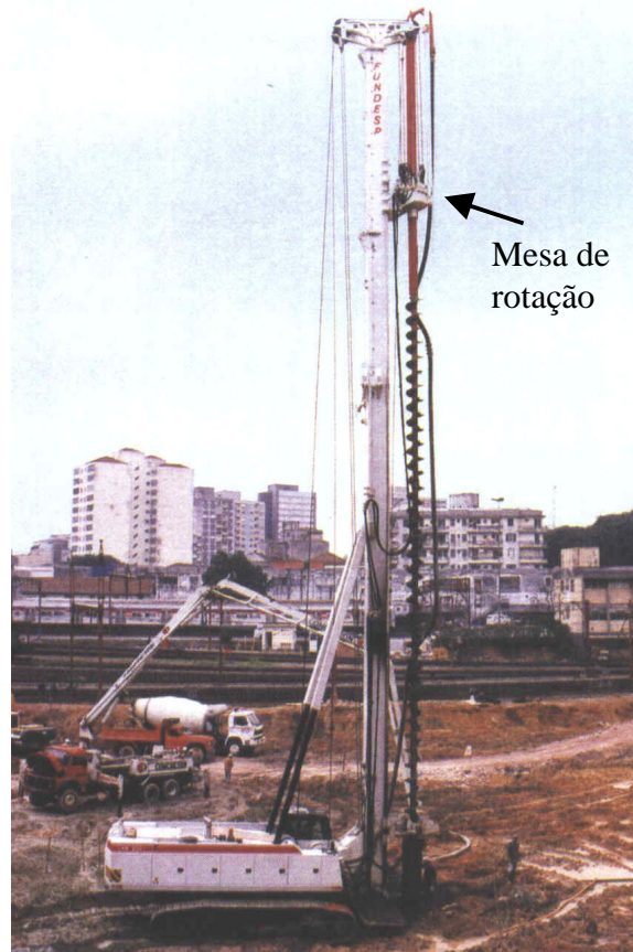
Figura 2.9 - equipamento de execução de estaca hélice contínua (FUNDESP, 2001)
