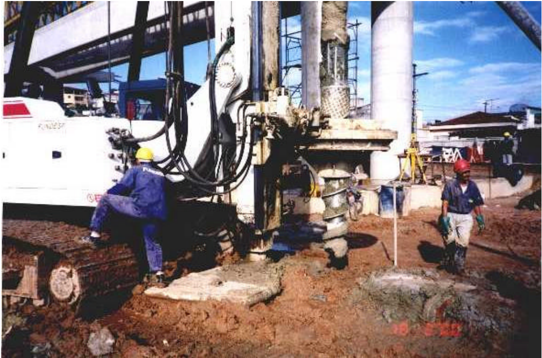
Foto 2.3 - preparo para iniciar a perfuração
