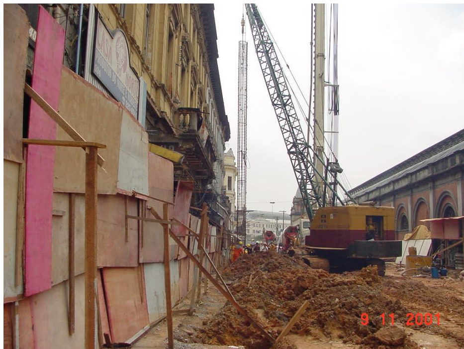
Foto 3.4 - proximidade dos equipamentos e da armadura na sua colocação com os prédios antigos da Rua Mauá.
