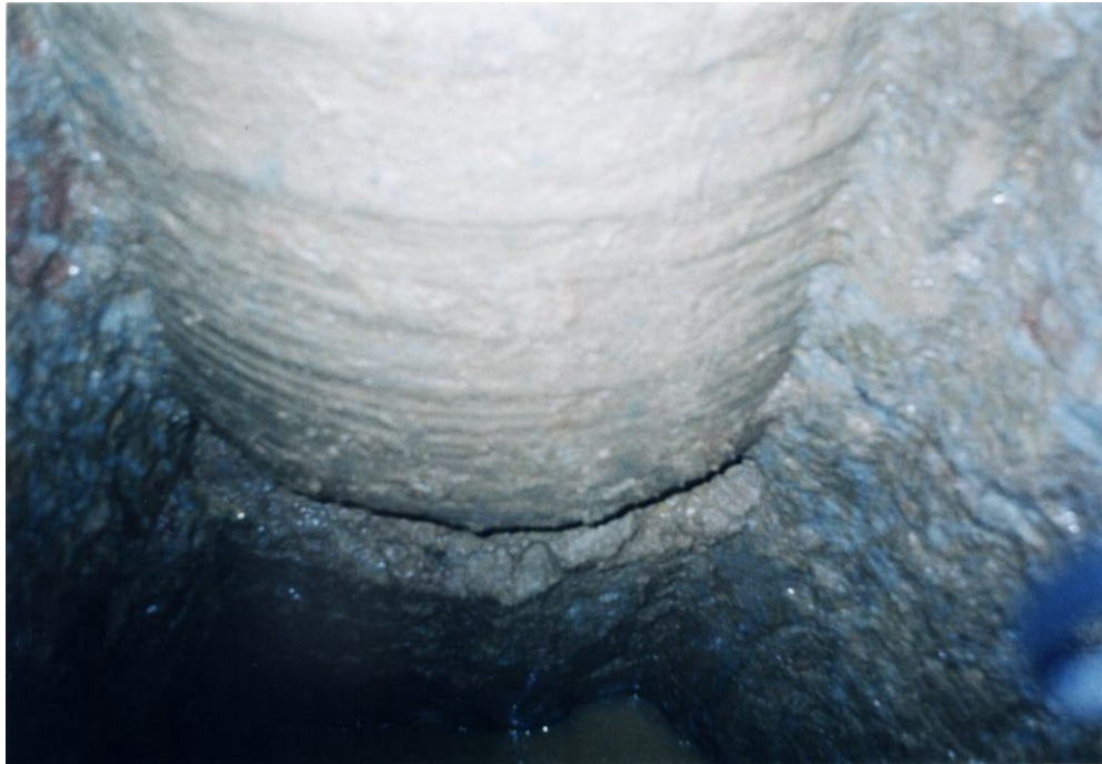
Foto 2.8 - visão superior do vazio no contato ponta-solo e do fuste da estaca (SOUZA, 2001)
