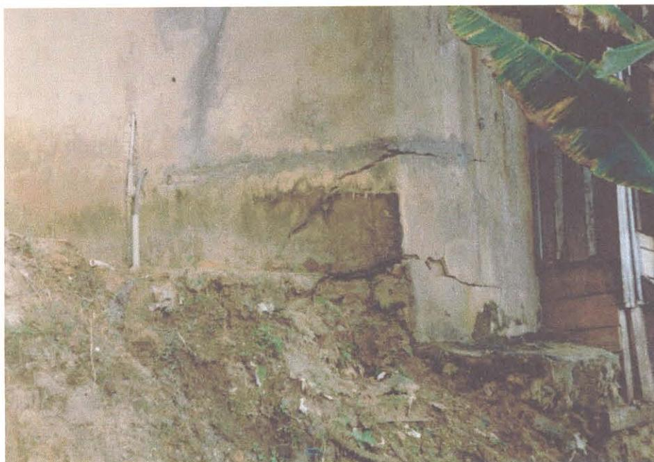
Figura 5.39 – Falésia ativa, na Praia do Bispo – Ilha do Mosqueiro – causando comprometimento das fundações de uma residência e trincamento da habitação.
