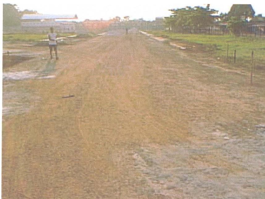
Figura 5.41 – Horizonte Ferruginoso, fácies Concrecionário, utilizado como base de pavimento em conjunto habitacional na Rod. Augusto Montenegro-Belém.
