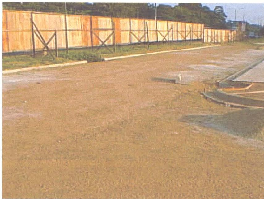
Figura 5.40 – Horizonte Ferruginoso, fácies Concrecionário, utilizado como base de pavimento em conjunto habitacional na Rod. Augusto Montenegro-Belém.
