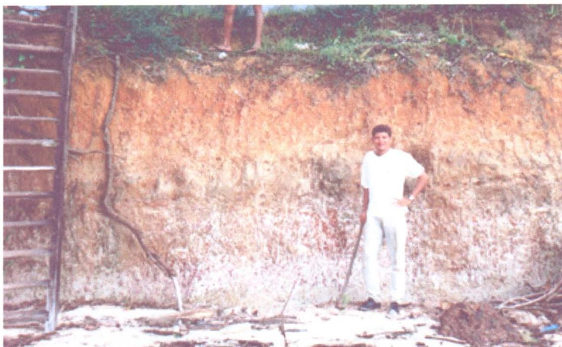
Figura 5.4 - Horizonte sedimentares da praia da Baía do Sol, apresentando total continuidade lateral. Do topo para a base temos: Horizonte Superficial, Horizonte de Solo (Pós-Barreiras - barro), seguidos pelo Horizonte Ferruginoso (fácies Concrecionário - piçarra) em contato com Horizonte Argiloso (fácies Argila Mosqueada)
