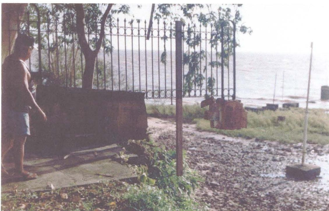
Figura 5.37 – Falésia ativa, nas proximidades do Hotel Farol – Ilha do Mosqueiro – onde parte do quintal de uma residência foi eliminado pela ação das ondas e das marés.
