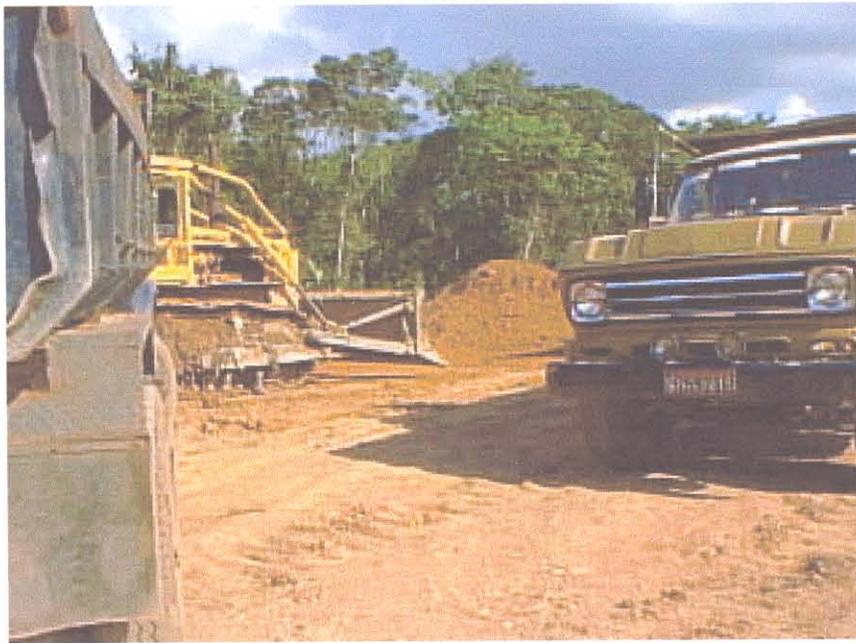
Figura 5.42 – Lixão do Aurá – local de extração de material para cobertura do lixo, no caso Horizonte Ferruginoso, fácies Concrecionário.
