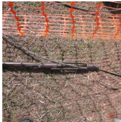
Figura 3.13: Tubulações passam pela haste onde a sonda será fixada (autor).
