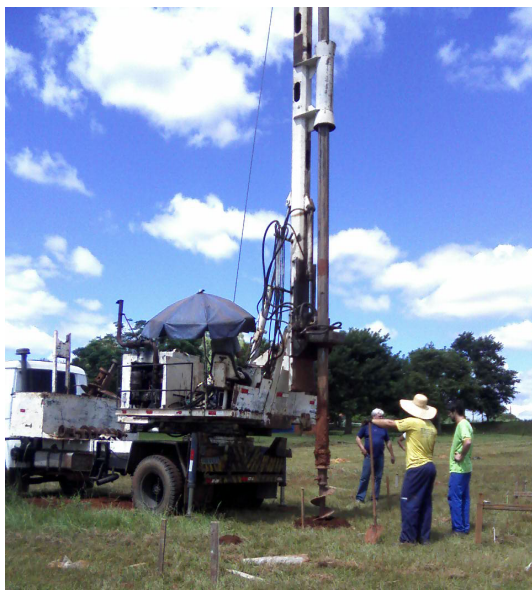
Figura 3.13 - Perfurção das estacas
