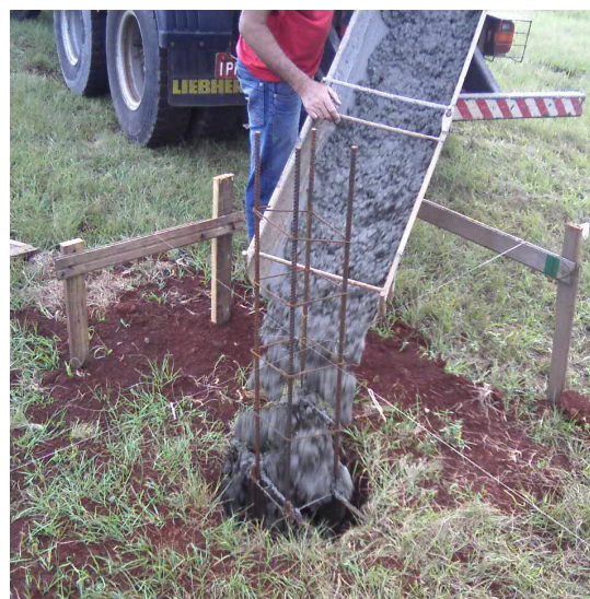
Figuras 3.15 e 3.16 - Concretagem das estacas com caminhão betoneira
