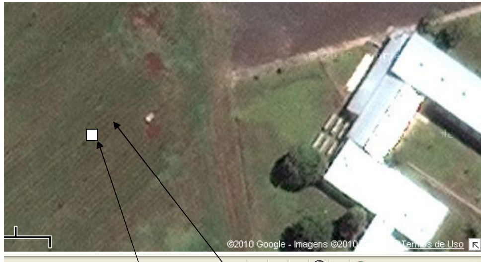
Figura 3.4 - Detalhe da área dos ensaios de placa e a trincheira
