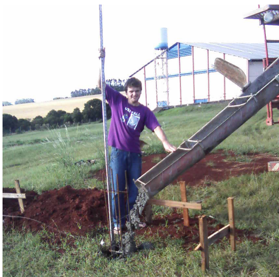
Figuras 3.15 e 3.16 - Concretagem das estacas com caminhão betoneira
