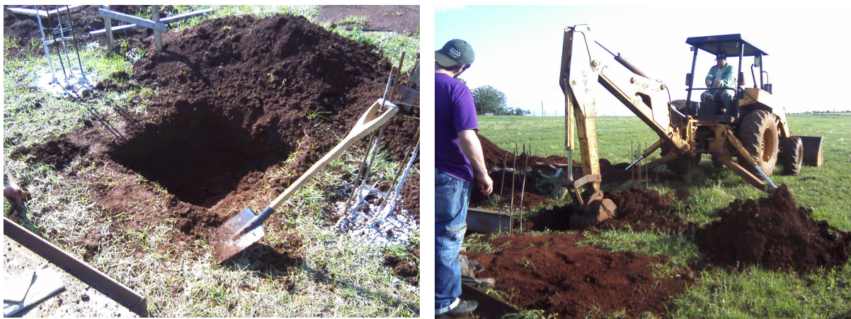
Figuras 3.17 e 3.18 - Escavação manual e mecânica com a retro-escavadeira
