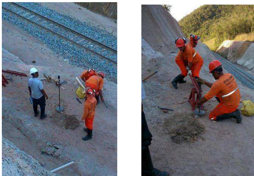
Figura 4-11: Execução de sondagens DPL.
