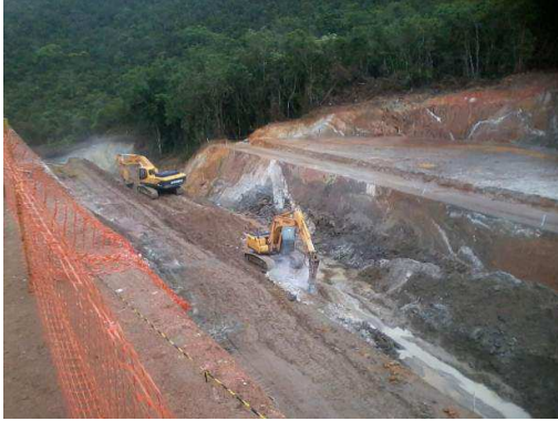
Figura 4-2: Foto da escavação em andamento (lado oposto)
