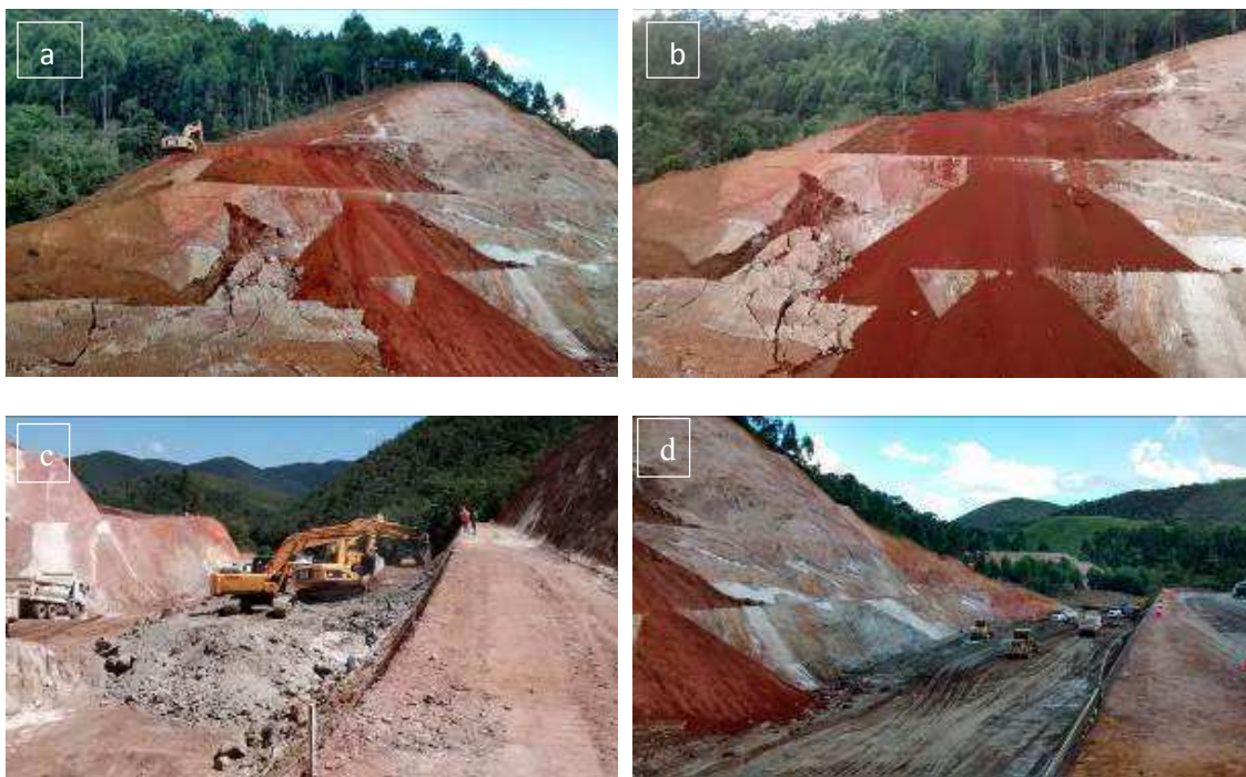
Figura 1-3: Imagens do local durante a escavação. (a) Escavação após movimentação do talude; (b) Vista frontal da área afetada; (c) Escavação em rocha no talude onde posteriormente foi executado o solo grampeado; (d) vista geral apresentado a etapa final de escavação da variante.
