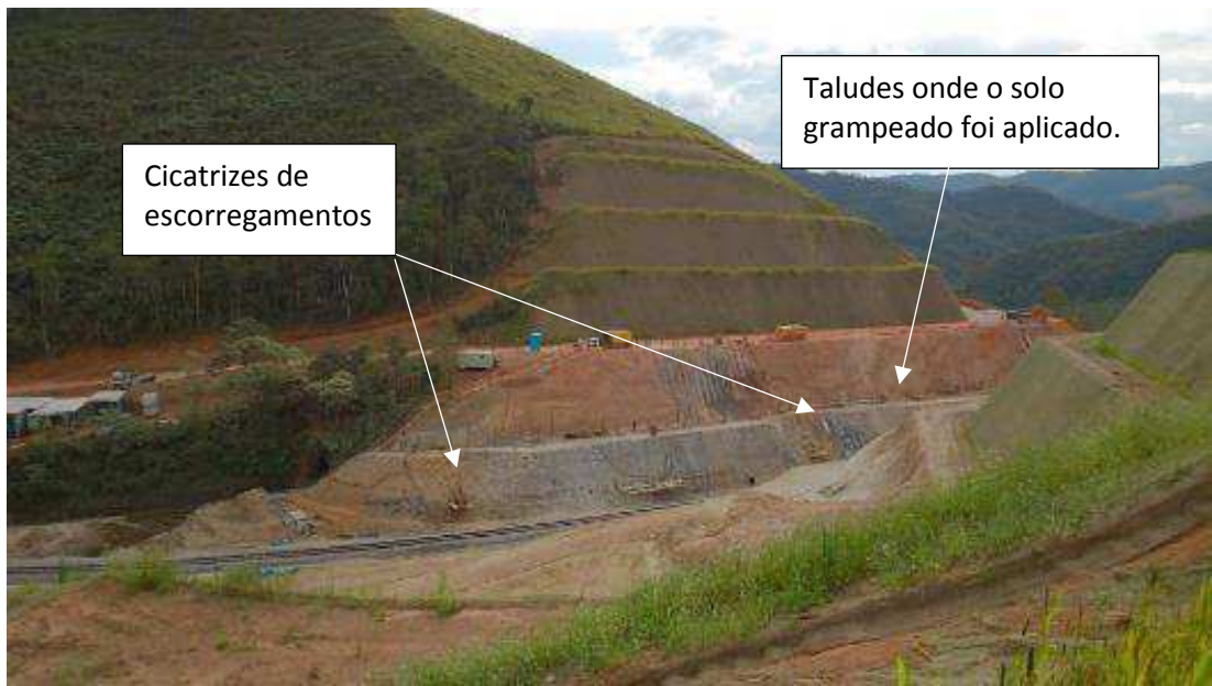
Figura 2-6: Vista geral da variante e da área de aplicação do solo grampeado.
