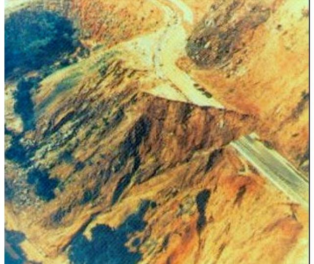
Figura 9 - Escorregamentos em cunha (retirada de <http://www.rc.unesp.br/igce/aplicada/ead/interacao/inter09b.html>)
