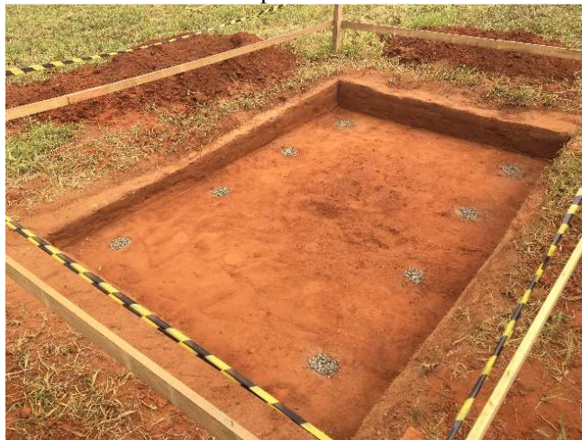
Figura 3.22 – Cava em formato cúbico e oito drenos preenchidos com brita.
