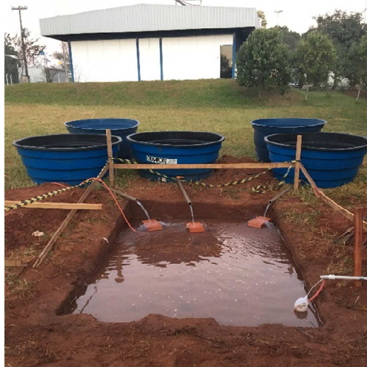
Figura 3.23 - Inundação da cava, as caixas d'água e sistema de boia utilizado na inundação da cava.
