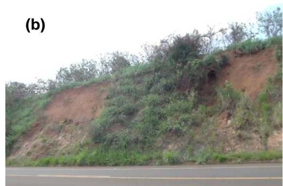
Figura 26 – Taludes na Formação Botucatu. (a) Rocha alterada mole com estratificação plano-paralela na S-2; e (b) Rupturas no solo residual na face norte do setor 1 (S-1 e S-2).
