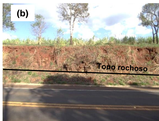
Figura 29 – Taludes nas Intrusivas Básicas Tabulares. (a) Cicatriz de escorregamento planar na S-8; (b) Colúvio sobreposto ao topo rochoso na S-12; (c) Solo de alteração com blocos de RAM-RAD na S-10; e (d) Linha de seixos na base do colúvio na S-12.
