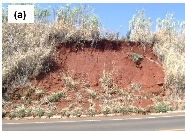
Figura 29 – Taludes nas Intrusivas Básicas Tabulares. (a) Cicatriz de escorregamento planar na S-8; (b) Colúvio sobreposto ao topo rochoso na S-12; (c) Solo de alteração com blocos de RAM-RAD na S-10; e (d) Linha de seixos na base do colúvio na S-12.
