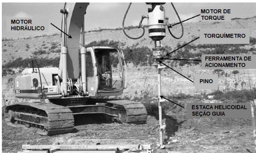
Figura 7 - Equipamento típico de instalação de estacas
