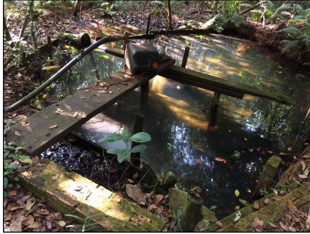
Figura 45. Caixa utilizada para represar as águas de fontes.
