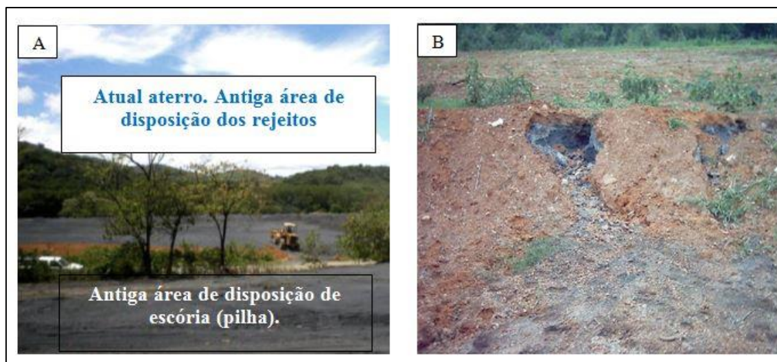
Figura 2 - (A) Construção do aterro de resíduos em 2006. (B) Escória coberta com camada fina de solo residual xistoso (imagem de 2006) – Adrianópolis – Vale do Ribeira.
