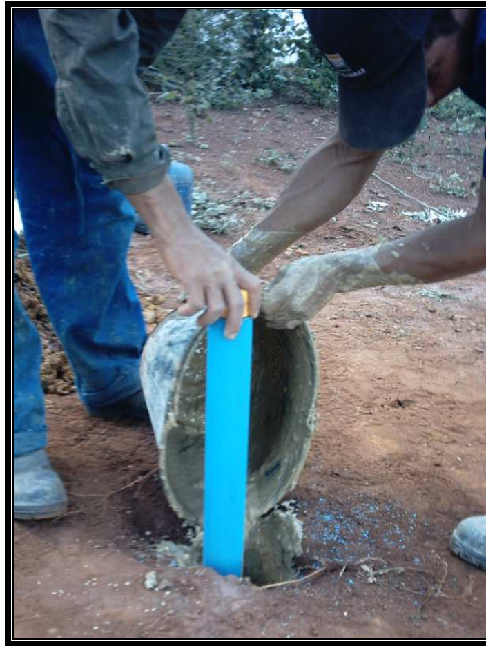
Foto 10 - Instalação do selo de bentonita.
