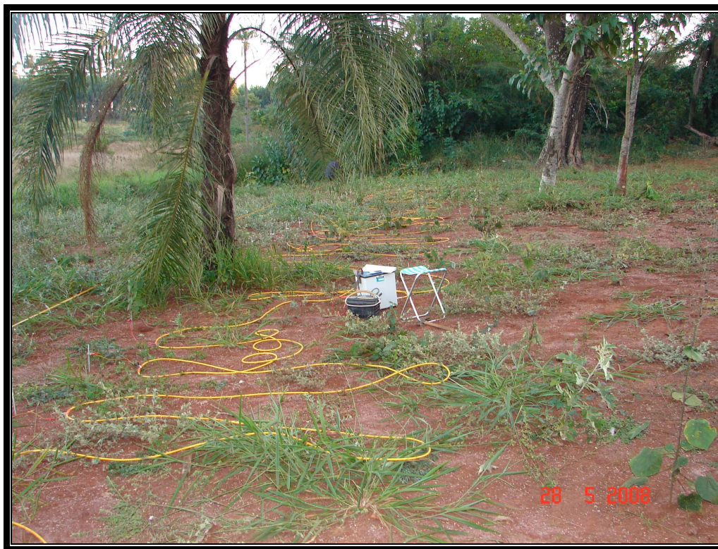
Foto 19 – Levantamento por Caminhamento Elétrico.
