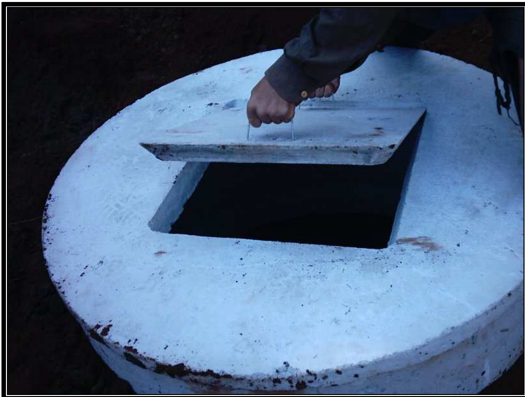
Foto 12 – Anel e tampa de concreto sobre o poço cacimba.
