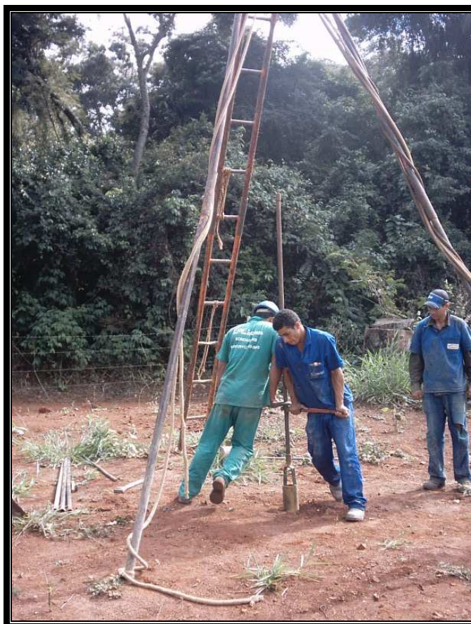
Foto 8 - Abertura de poço de monitoramento com sonda de 4 polegadas e tripé.
