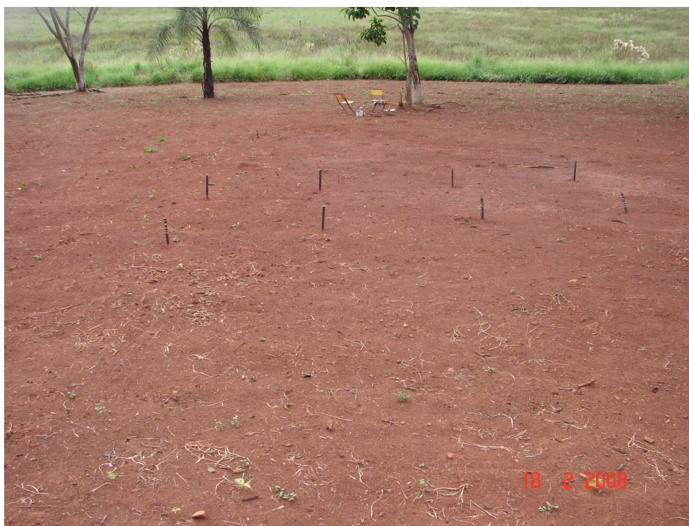
Foto 7: Detalhe da área já limpa tendo ao centro a vala demarcada.
