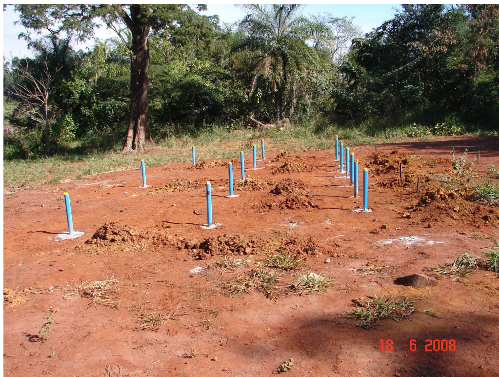
Foto 13 – Área com poços de monitoramento instalados antes da abertura da vala.
