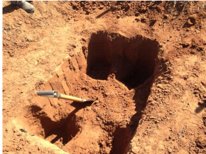
Figura 35 - Procedimentos para abertura da trincheira
