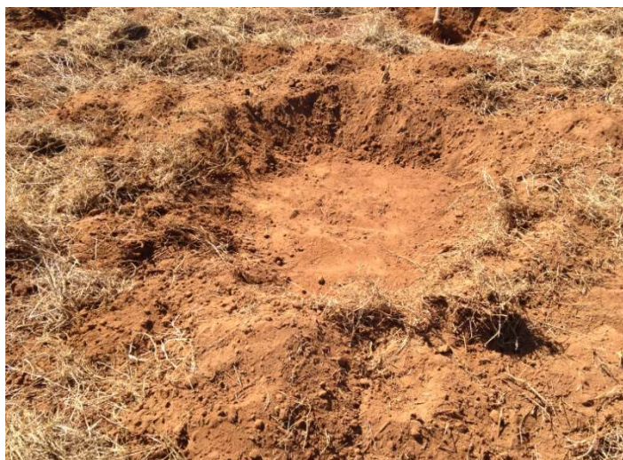
Figura 41 - Foto do local com a retirada da camada revolvida do solo.
