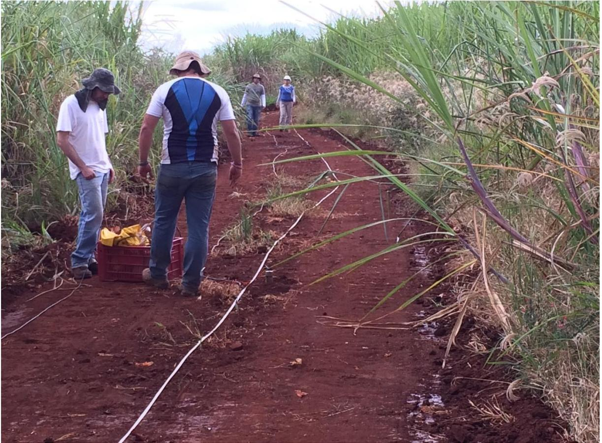
**Figura 26** - Levantamento de campo das linhas de caminhamento elétrico.
